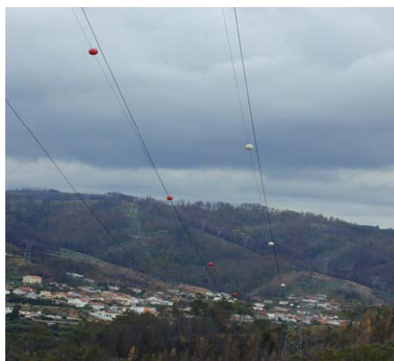
Figura 2.10: Balizagem diurna das linhas
