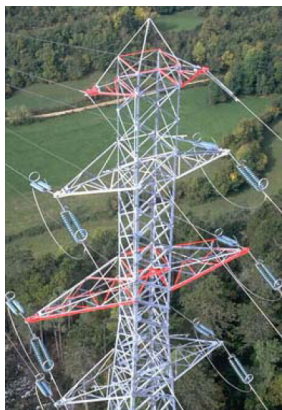
Figura 2.11: Balizagem diurna dos apoios
