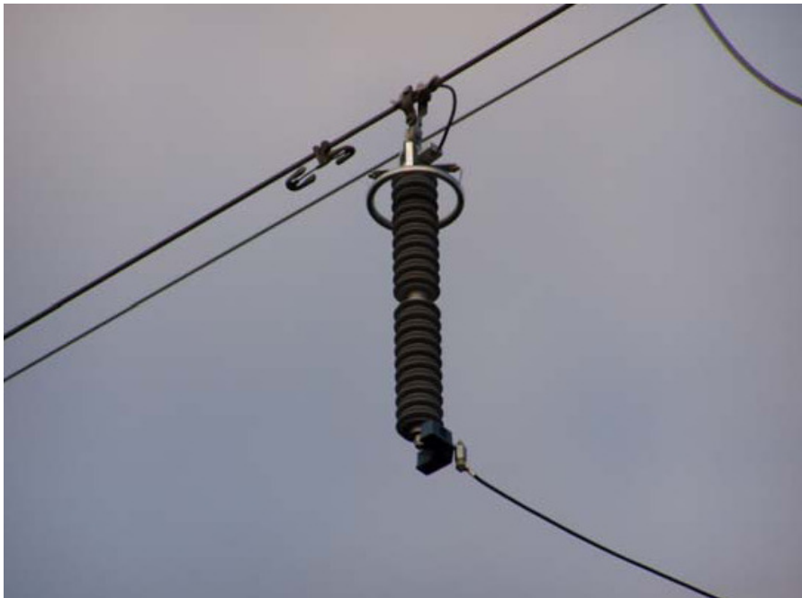
Figura 2.6: Descarregador de sobretensão
