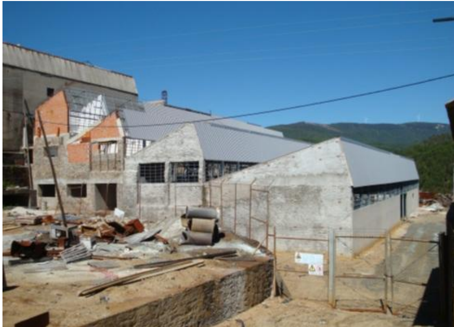
Figura 29 - Antiga lavaria do Cabeço do Pião em reabilitação.
