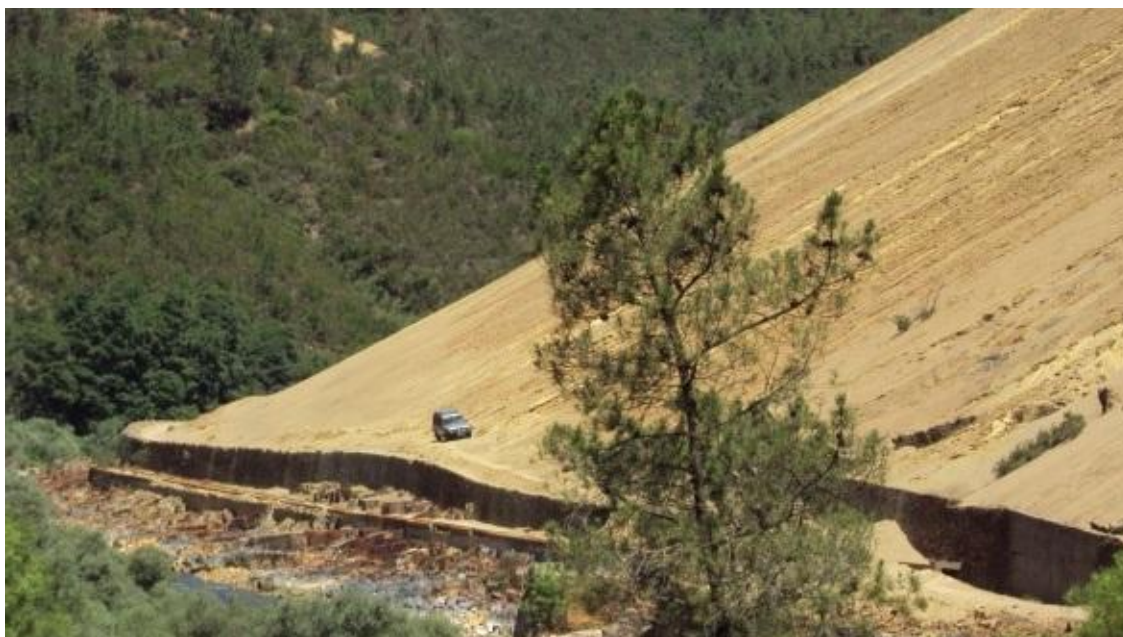
Figura 47 - Vista da base do talude da barragem de lamas.
