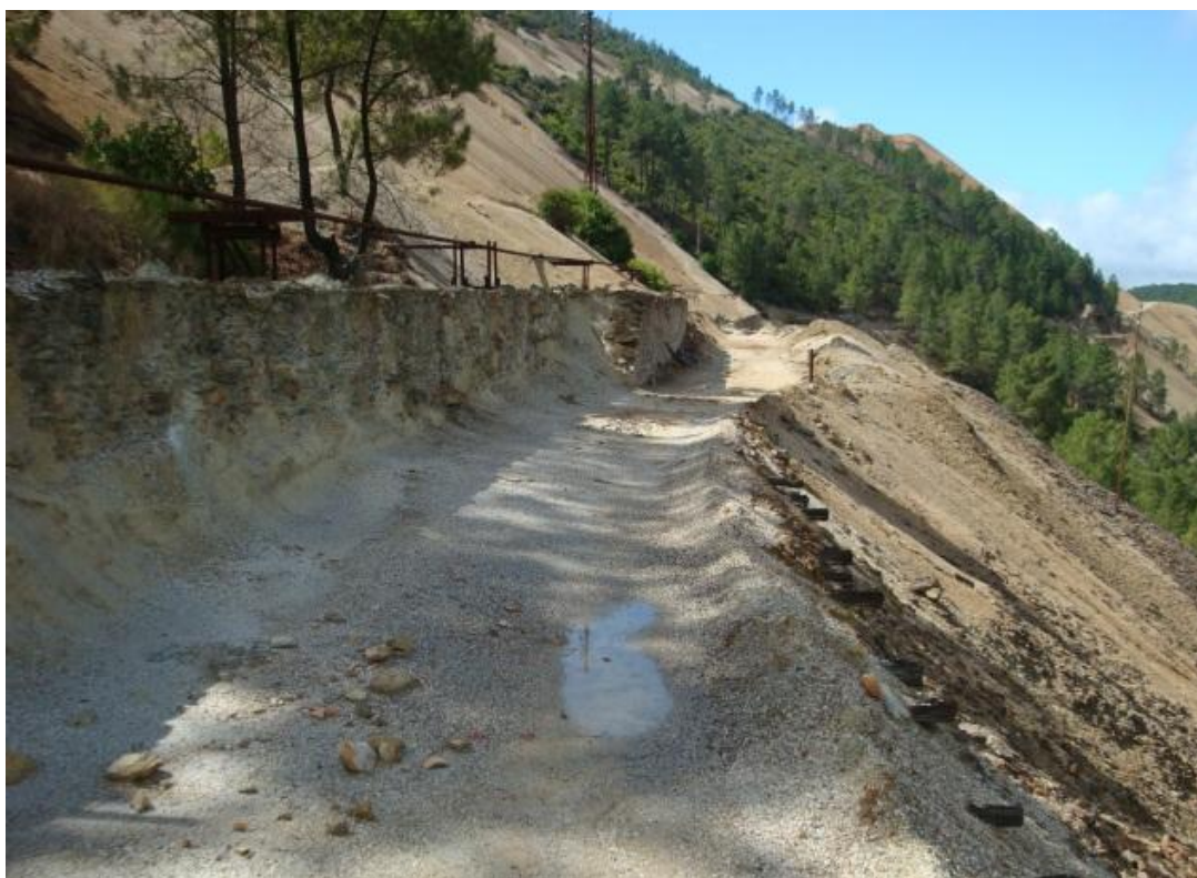
Figura 33 - Degradação do caminho de circulação automóvel.
