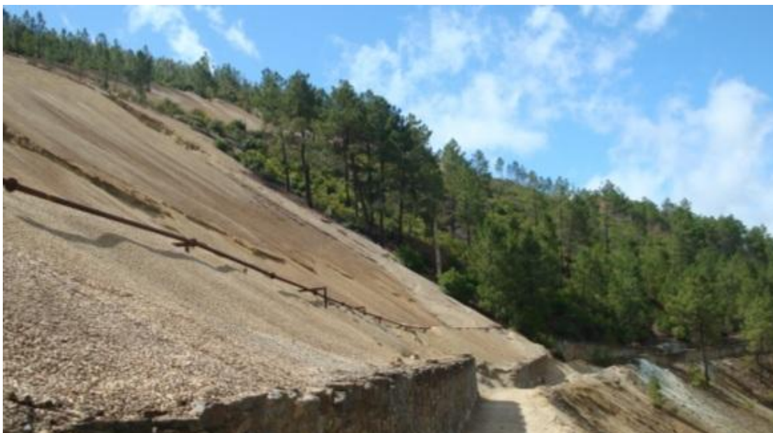
Figura 32 - Fotografia do caminho estreito, com a visualização da tubagem.
