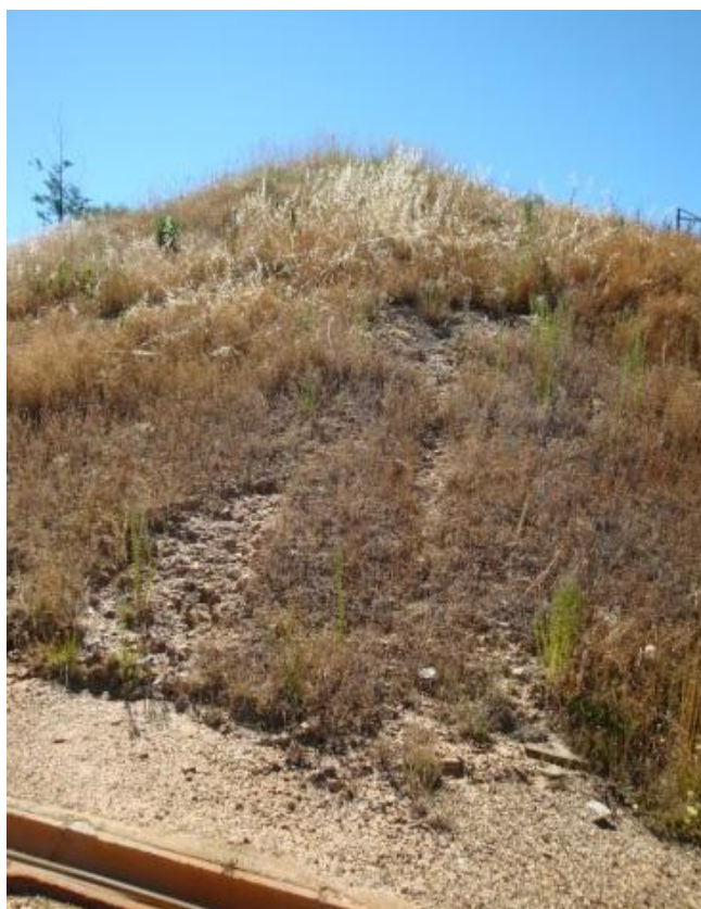
Figura 19 - Escorregamentos na pilha de sulfuretos.
