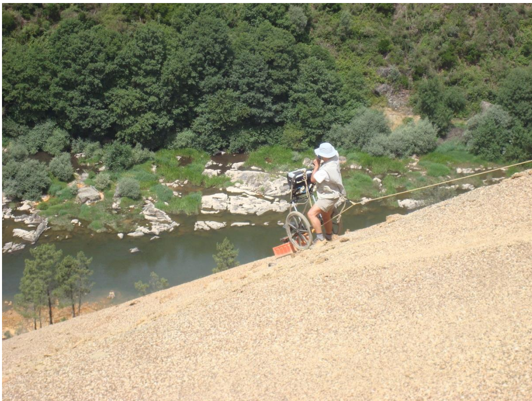
Figura 67 – Visualização da descida do talude com o radar de solos.
