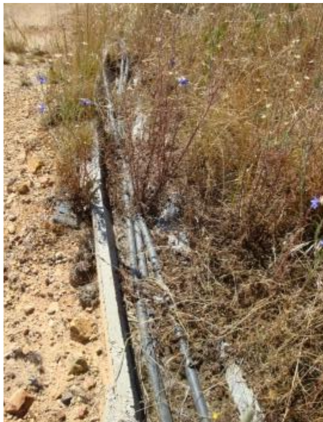
Figura 18 - Canal de escoamento da pilha de sulfuretos.
