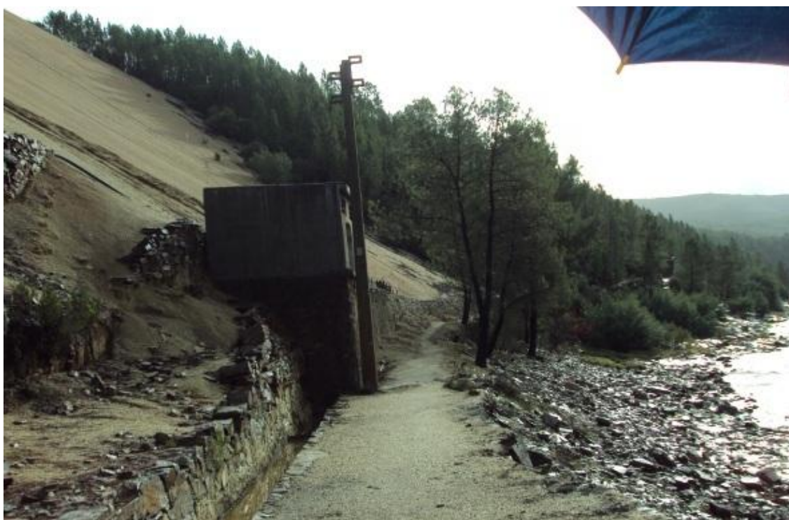
Figura 49 - Central de bombagem de lixiviados.
