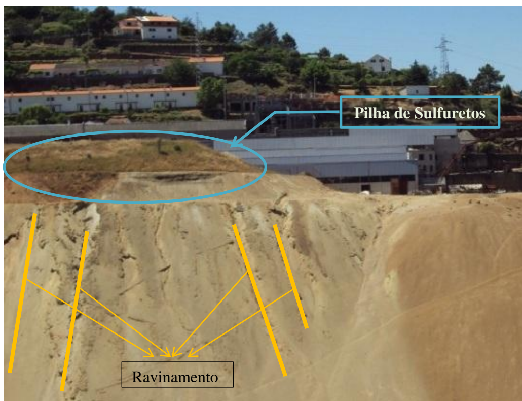
Figura 21 - Ravinamentos lineares na parte lateral da escombreira, adjacente à pilha de sulfuretos.
