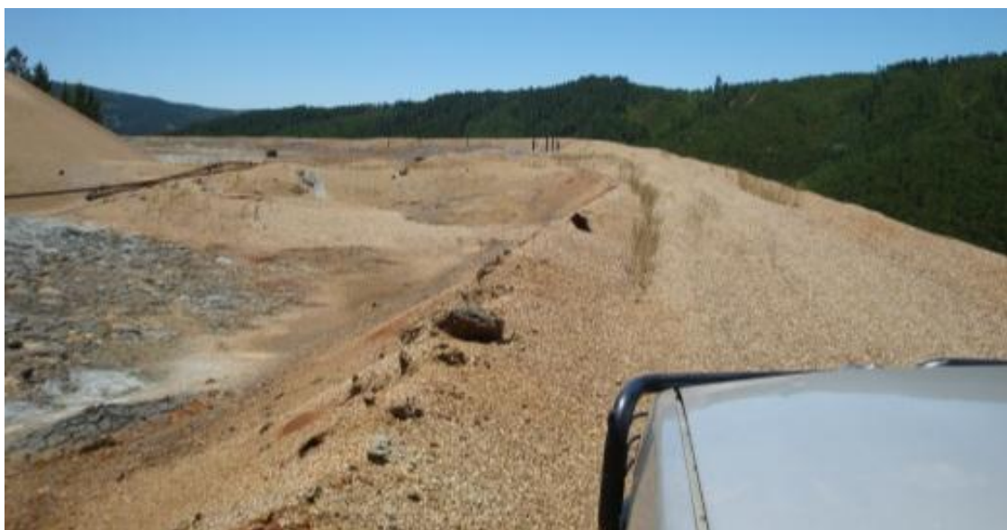
Figura 39 - Parte inicial da barragem de lamas (Área A).
