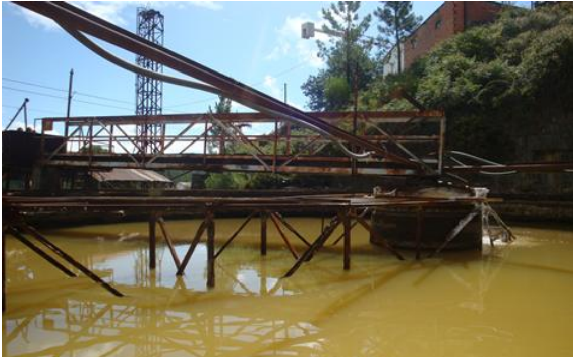
Figura 25 - Interior do tanque de neutralização com vista da descarga de lixiviado.
