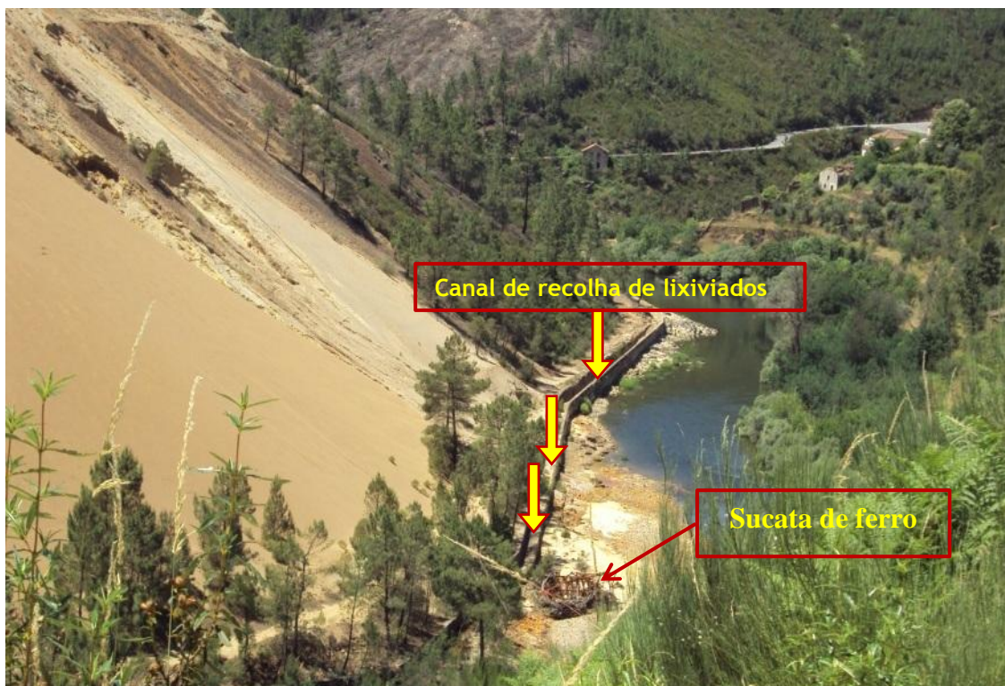
Figura 30 - Visualização da erosão acentuada no talude e da vegetação que precede esta zona recobrindo a encosta.
