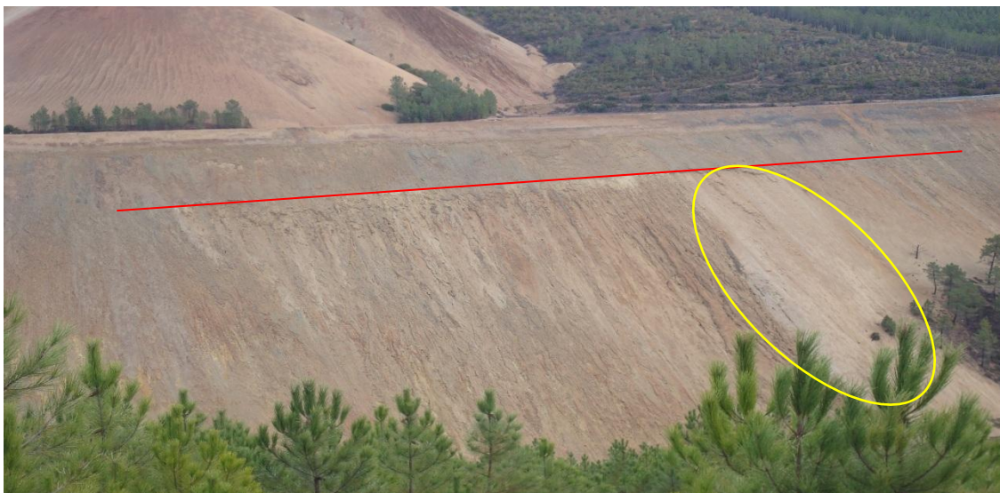
Figura 46 - Vista frontal do talude da barragem de lamas.
