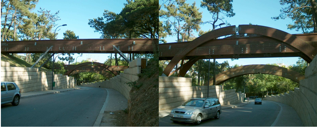
Fig.5.13 – Passadiços de madeira localizados na Pasteleira, Porto
