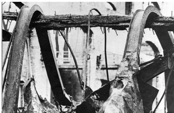
Fig.2.14 – Vigas de madeira, submetidas a um severo incêndio, sofreram uma redução de secção mas mantiveram a capacidade de suporte do peso próprio e das vigas de aço, que entraram em colapso.
