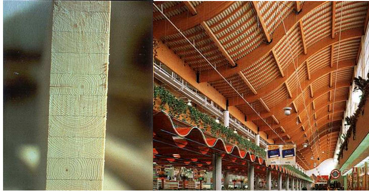
Fig.2.21 – Secção de madeira lamelada colada
