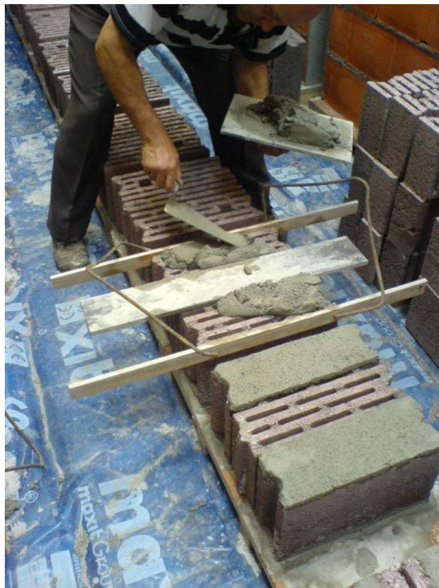
Figura 6 – Pormenor de execução das juntas horizontais
