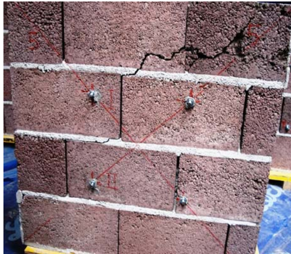
Figura 18 – Aspecto dos provetes da série B após rotura
