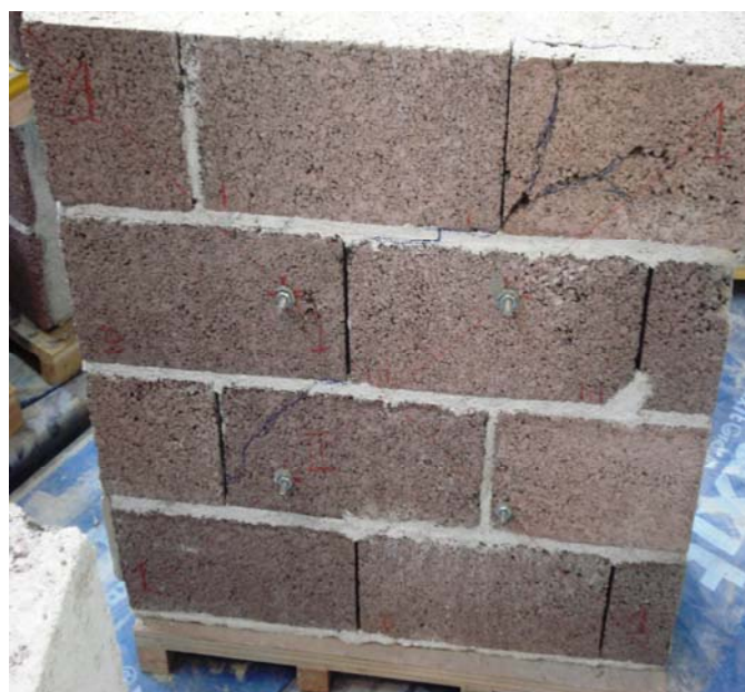
Figura 17 – Aspecto dos provetes da série A após rotura
