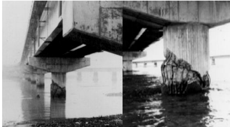
Fig. 2.18 – Sismo de Urakawa-Oki, 1982 (Japão). Rotura por corte
