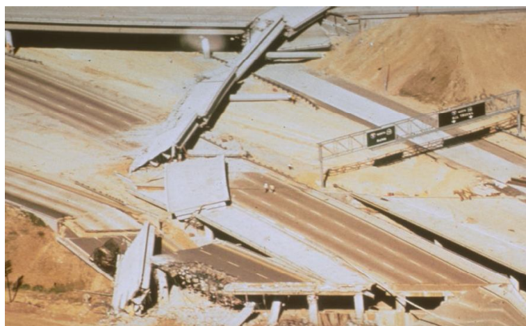
Fig. 2.6 – Sismo de San Fernando, 1971 (EUA). Colapso por assentamento das fundações.
