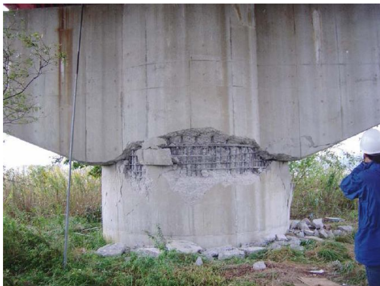
Fig. 2.20 – Sismo de Niigata (Japão). Rotura por corte
