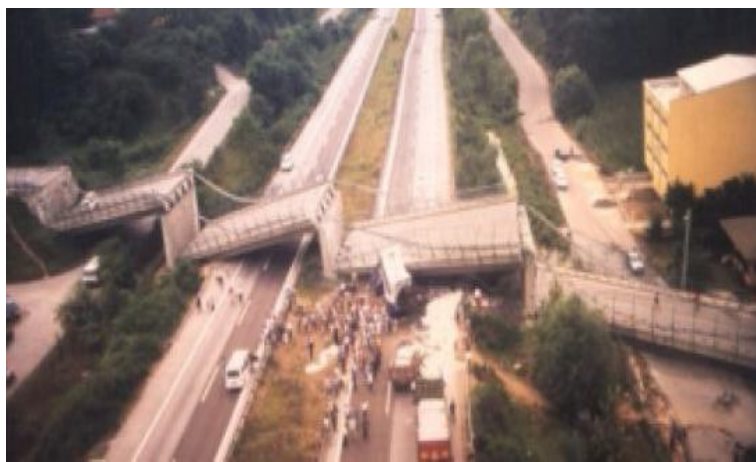
Fig. 2.4 – Sismo de 1999 (Turquia). Queda da passagem superior de Arifye.
