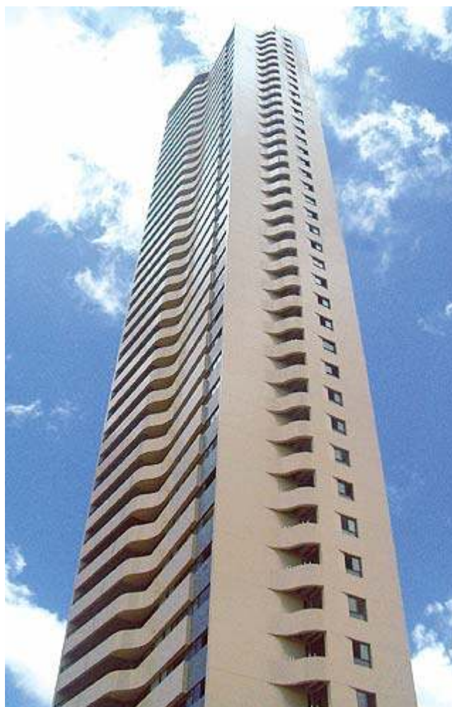
Fig. A.1 – Com 46 lajes, o edifício Terra Brasilis tem 130 metros de altura e fachadas revestidas por composição de cerâmica 7,50 x 7,50 cm e porcelanato no formato 30 x 30 cm. Projecto do arquitecto Bruno Ferraz construído em Recife
