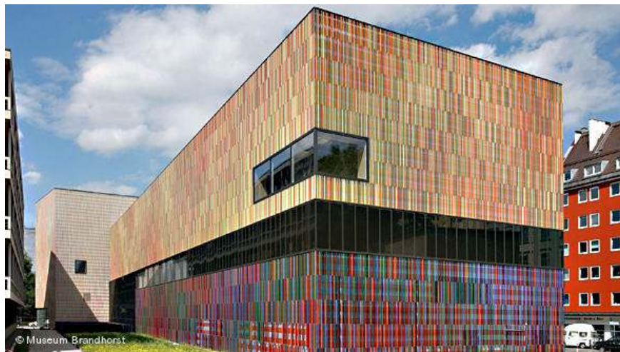
Fig. 1.1– Museum Brandhorst: plaquetas cerâmicas escondem isolamento e reflectem o interior [1]
