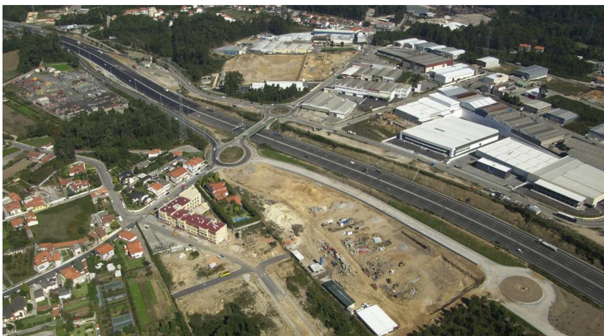
Figura 4.11 – Nó incompleto da A1, junto à área industrial de Grijó, Outubro de 2003 [2]
