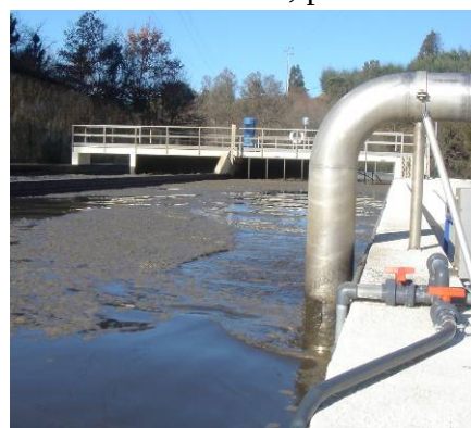
Figura 9 - Sistema de Recirculação de Lamas.
