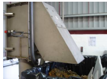
Figura 4 - Compactador/Tamizador vertical do tipo “Rotamat”.
