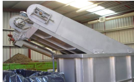
Figura 7 - Escumador (concentrador) de gorduras.
