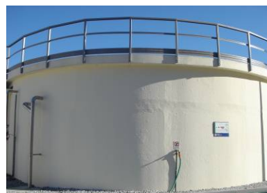
Figura 26 - Espessador mecânico de lamas brutas.
