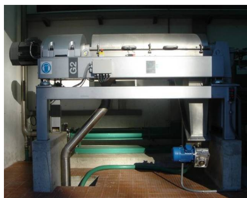
Figura 27 -Centrífuga Horizontal, responsável pela desidratação de lamas.
