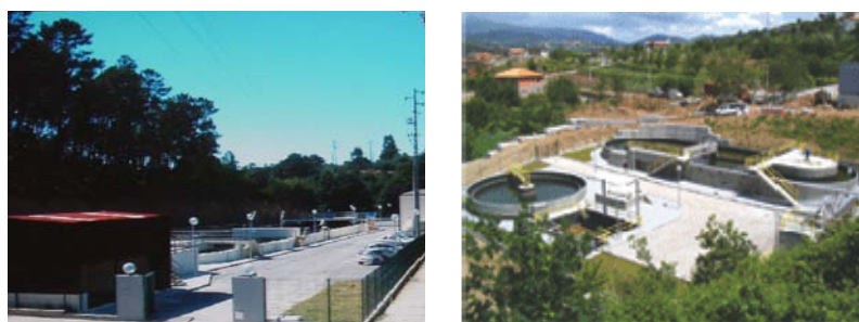
Figura 1 - Infra-estruturas concebidas pela EFACEC Ambiente S.A.
