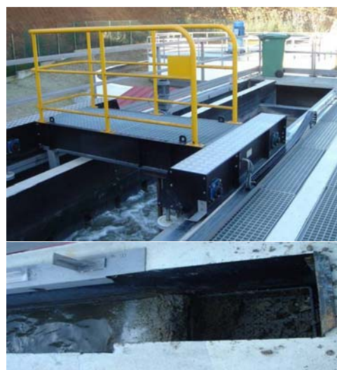
Figura 5 - Tanque rectangular, onde ocorre a fase de desarenamento e desengorduramento do afluente (imagem superior) e remoção de algumas gorduras (volumosas) com um recipiente improvisado (imagem inferior).
