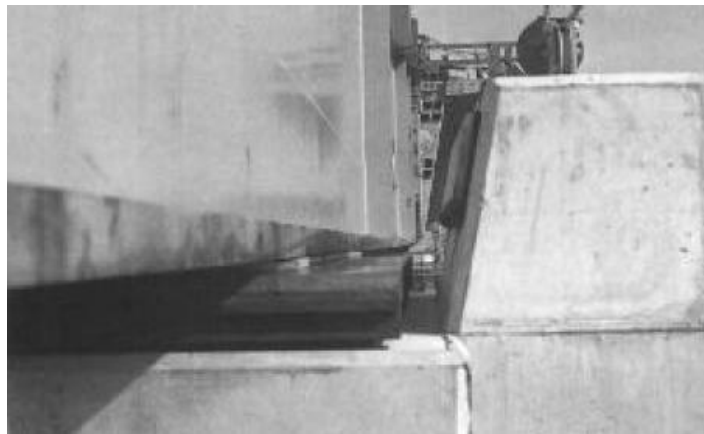
Fig. 3.3. – Dispositivo de escorregamento com guia lateral. [8]
