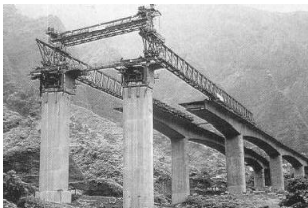
Fig. 3.11. – Viga superior de lançamento na construção de um tabuleiro. [8]
