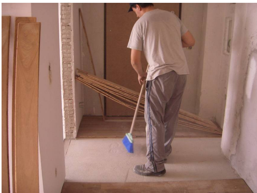
Fig. 3.18 – Limpeza da prévia da betonilha.
