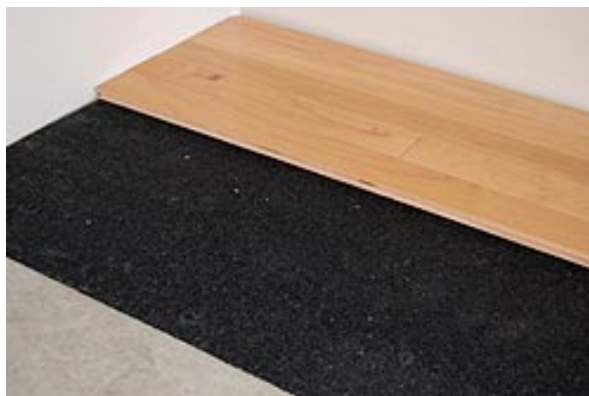
Fig. 5.6 - Soalho pousado sob manta resiliente [33].
