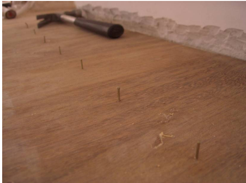
Fig. 3.20 – Fixação com pregos ao longo do perímetro do Soalho.
