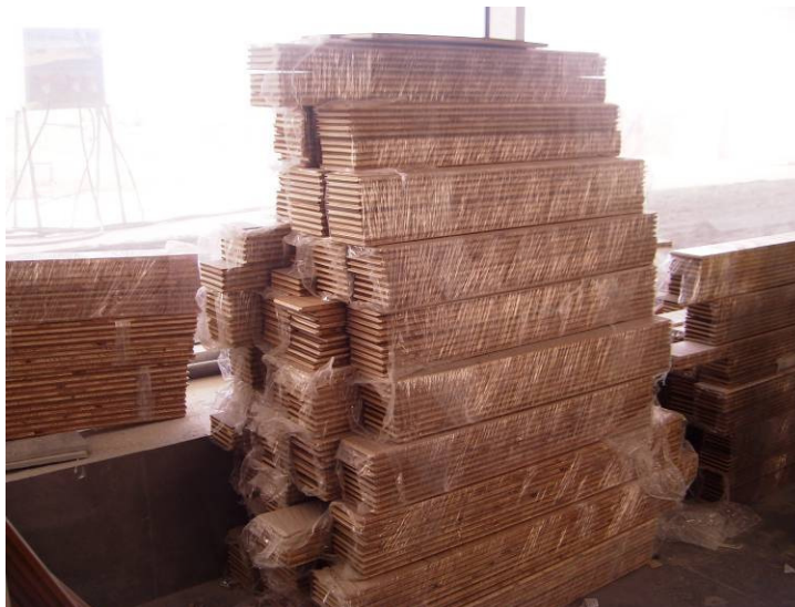
Fig. 3.16 – Recepção do soalho “ Ingenious ” em obra.
