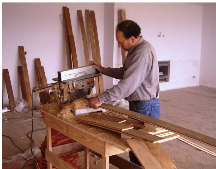
Fig. 3.17 – Corte das régua para aplicação.
