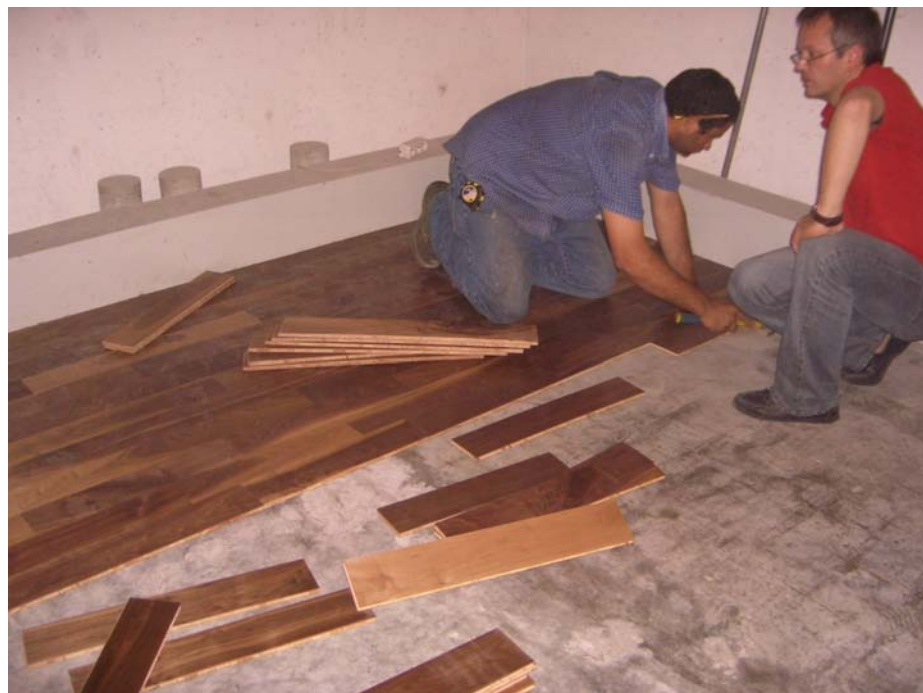
Fig. 5.11 - Aplicação do soalho “ Ingenious ” de Nogueira com 14 mm na câmara E1.
