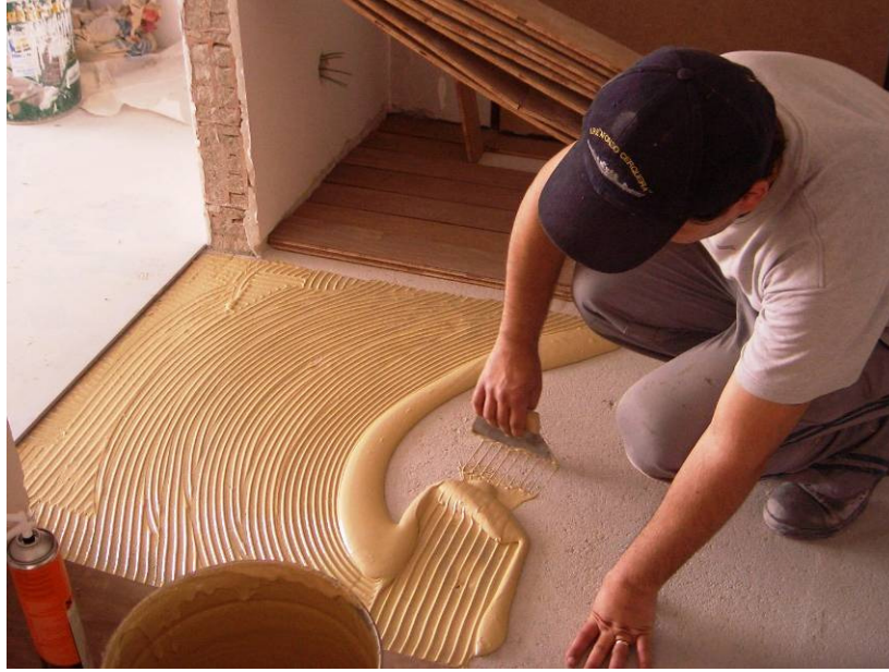
Fig. 3.19 – Aplicação da cola.
