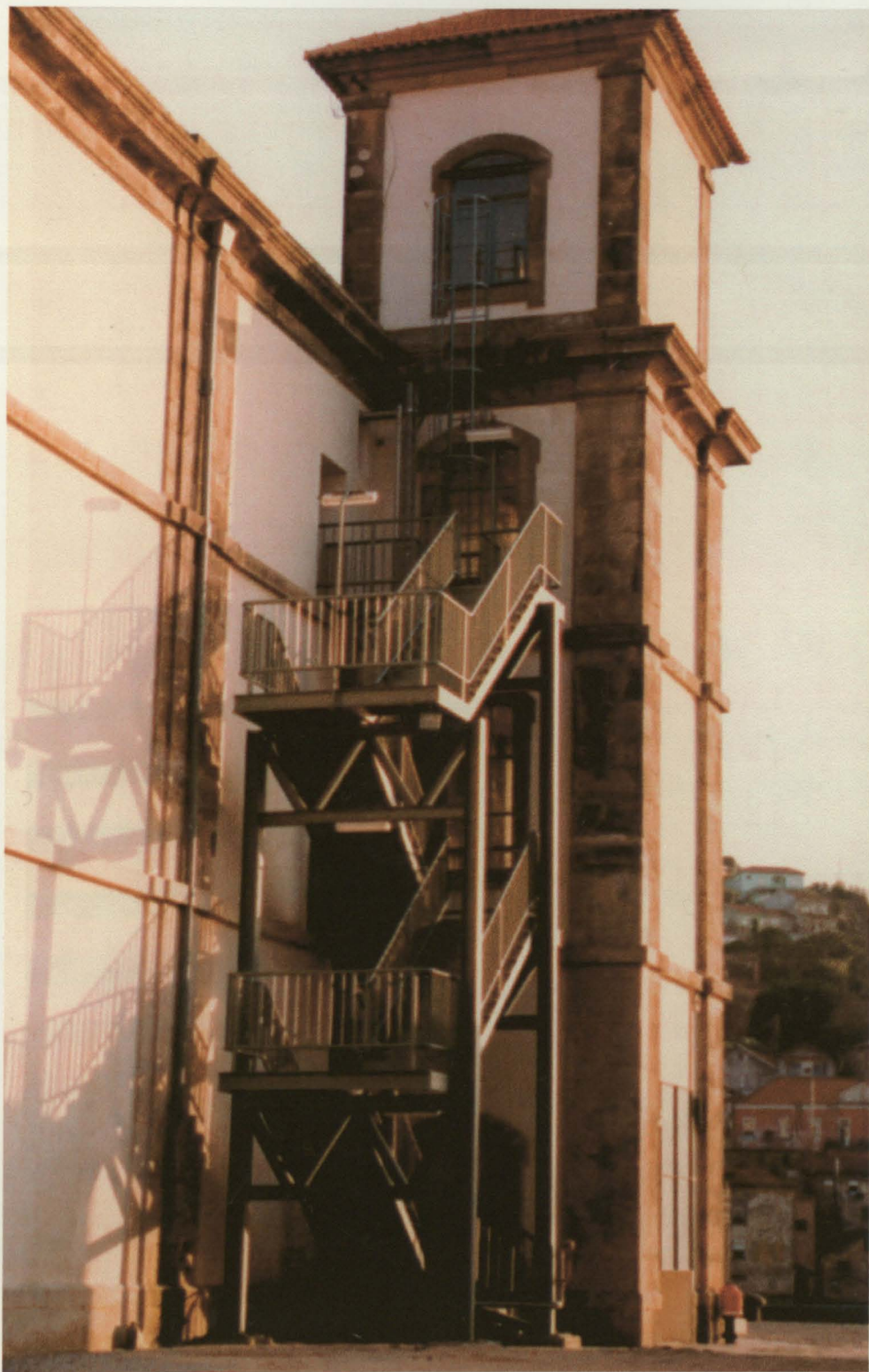
FIG. 64 - EDIFICIO DA ALFANDEGA, PORTO
