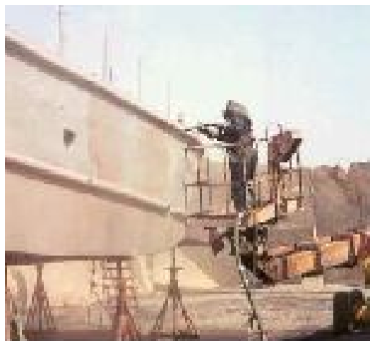
Figura 7. Decapagem de superfícies metálicas [7].
