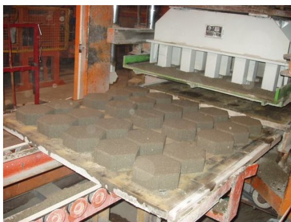
Figura 117. Fabrico de pavês: desmoldagem.
