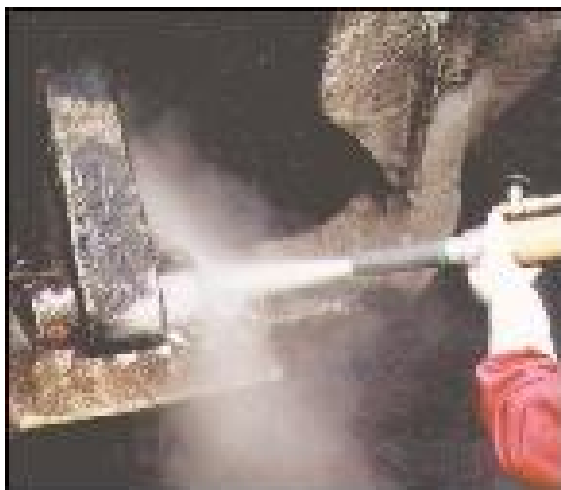
Figura 6. Decapagem de superfícies metálicas [6].
