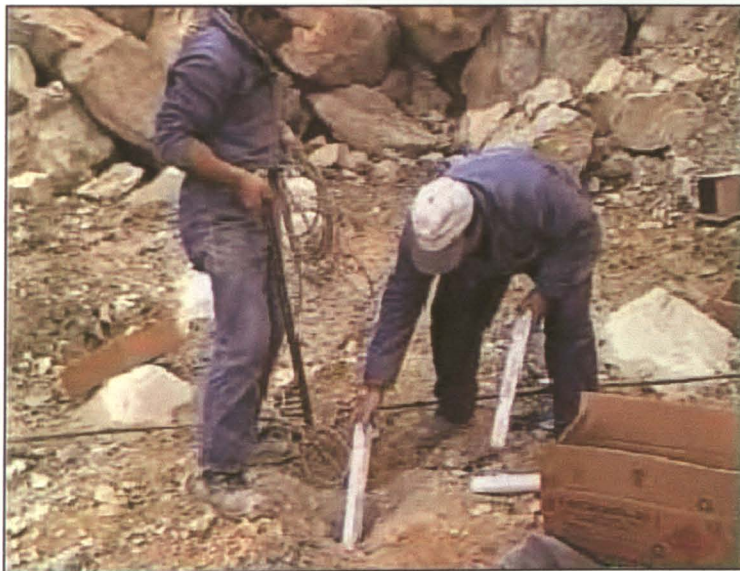
Foto 10- Operação de carregamento dos furos. Pode-se ver o carregador de fogo (direita), e um servo (esquerda) com um dispositivo utilizado quando existe dificuldade na carga.
