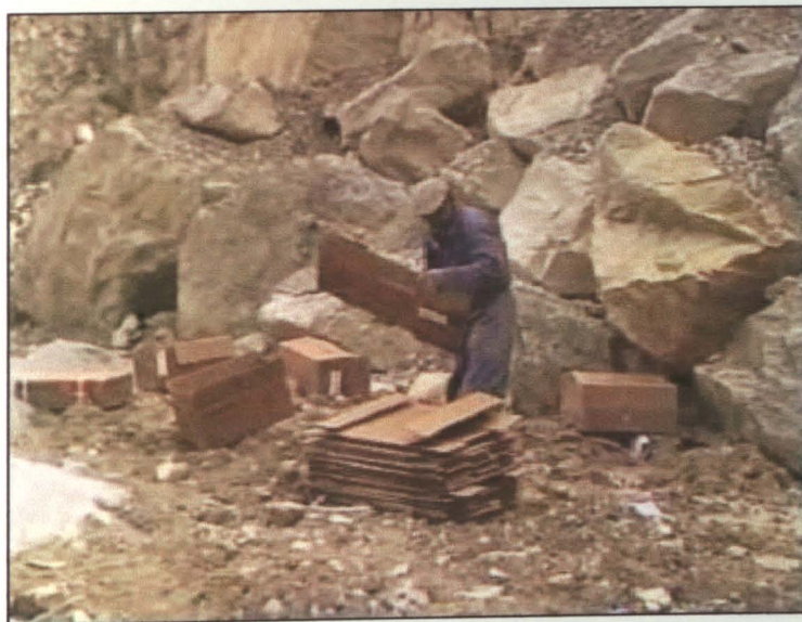
Foto 20- Operação de remoção do material resultante do carregamento da frente de desmonte.
