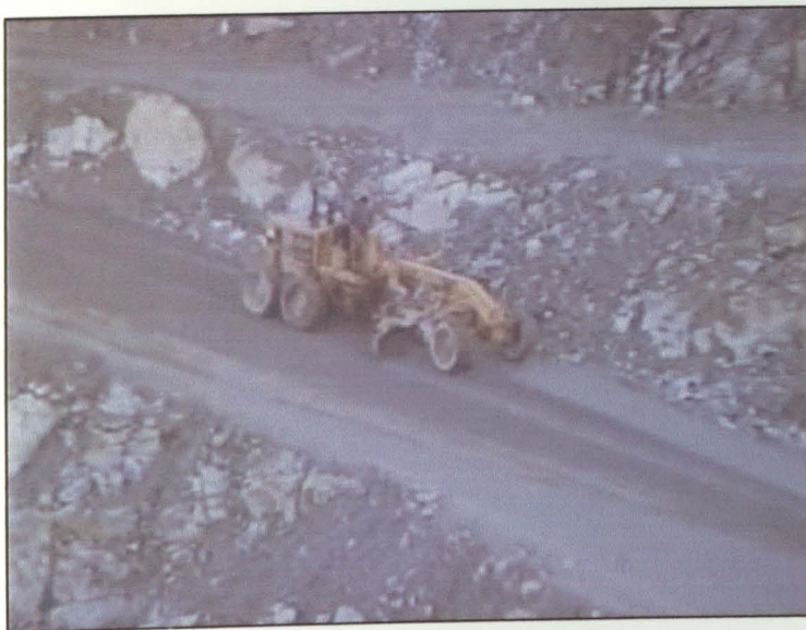
Foto 36- Motoniveladora a reparar o piso na pedreira da Malaposta.
