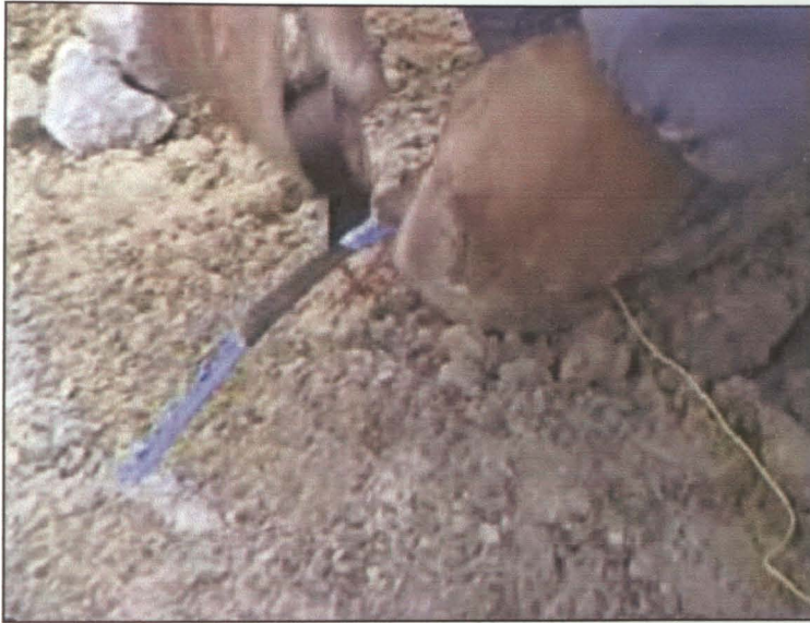
Foto 22- Processo de ligação do detonador ao cordão detonante.
