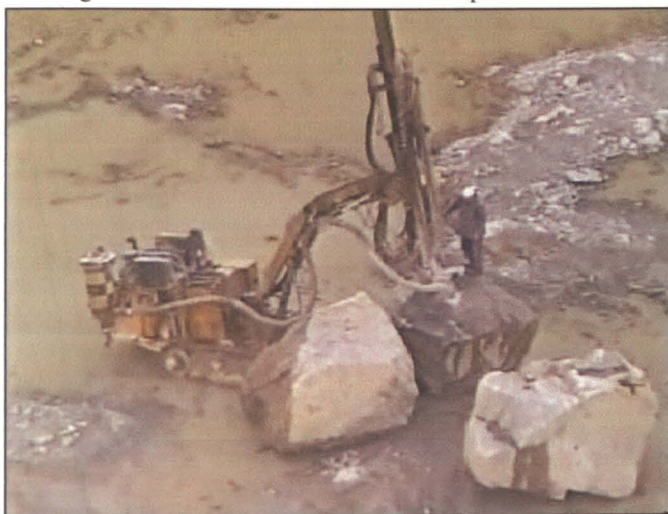
Foto 6- Perfuração secundária executada na pedreira da Madalena
