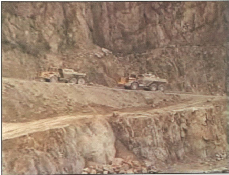
Foto 35- Dumper de 20 Toneladas (esquerda) e 35 toneladas (direita) em transporte na pedreira da Malaposta.
