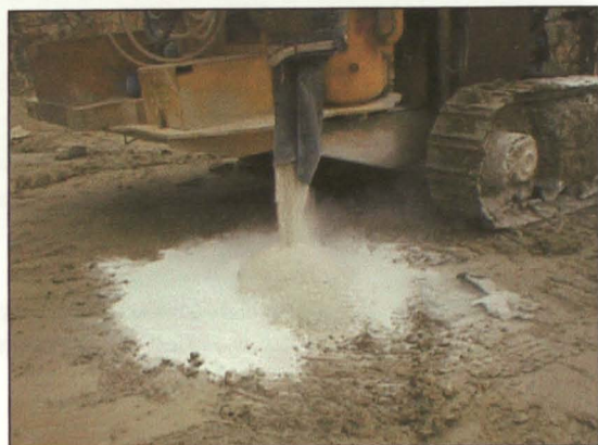
Foto 7- Sistema de despoejamento.
