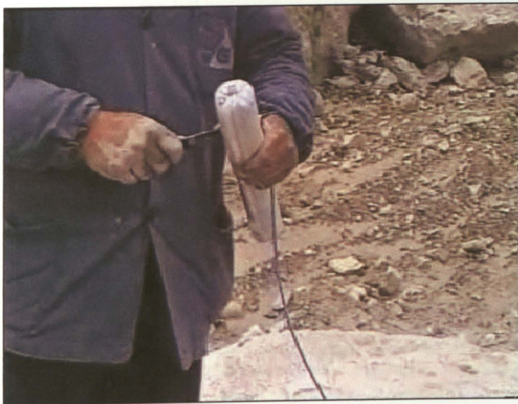
Foto 13- Escorvamento do primeiro cartucho a introduzir no furo. O orifício vai servir para a passagem do cordão detonante.
