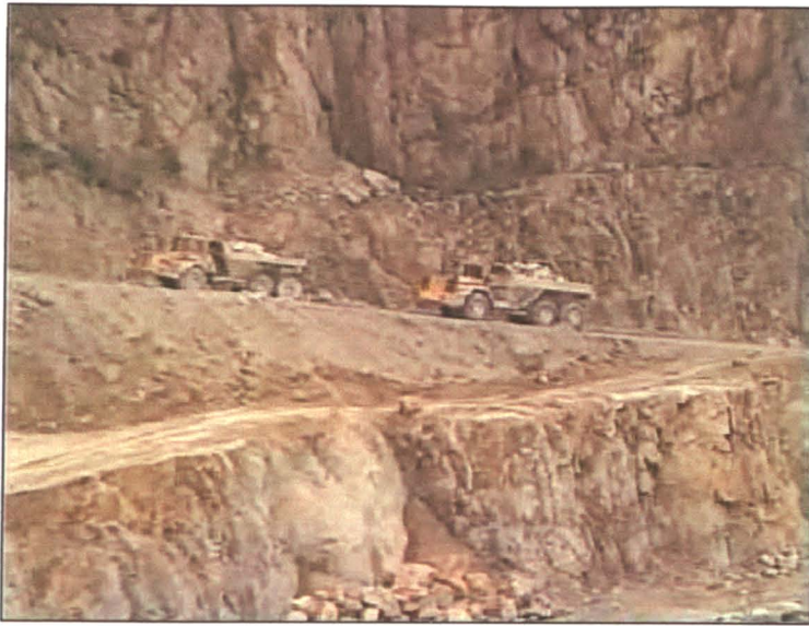
Foto 3- Transporte em dumper na pedreira da Malaposta
