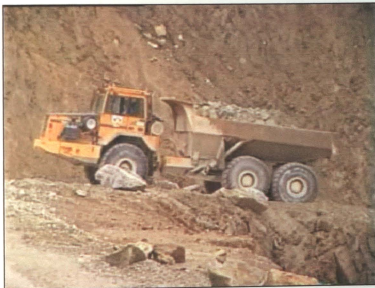
Foto 28- Dumper de 35 toneladas em transporte na pedreira da Malaposta.
