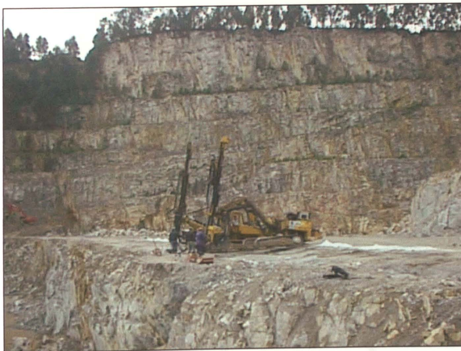
Foto 5- Perfuração sub-vertical realizada para o desmonte das frentes. Nesta imagem pode-se observar os carros de perfuração e os respectivos operadores na pedreira da Malaposta.
