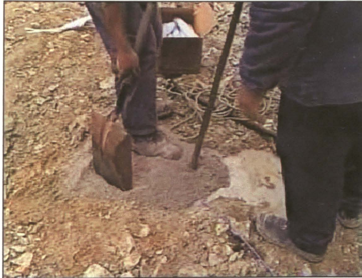
Foto 14- Tamponamento e atacamento de um furo.
