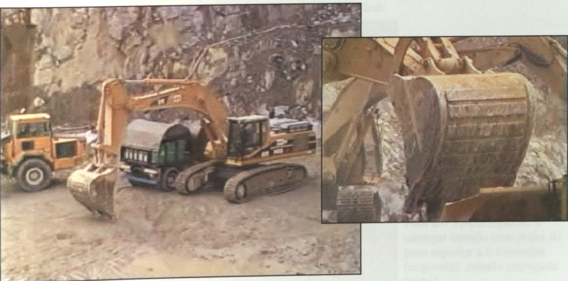
Foto 26- Retro escavadora a ser abastecida (esquerda); pormenor do balde da retro escavadora (direita).
