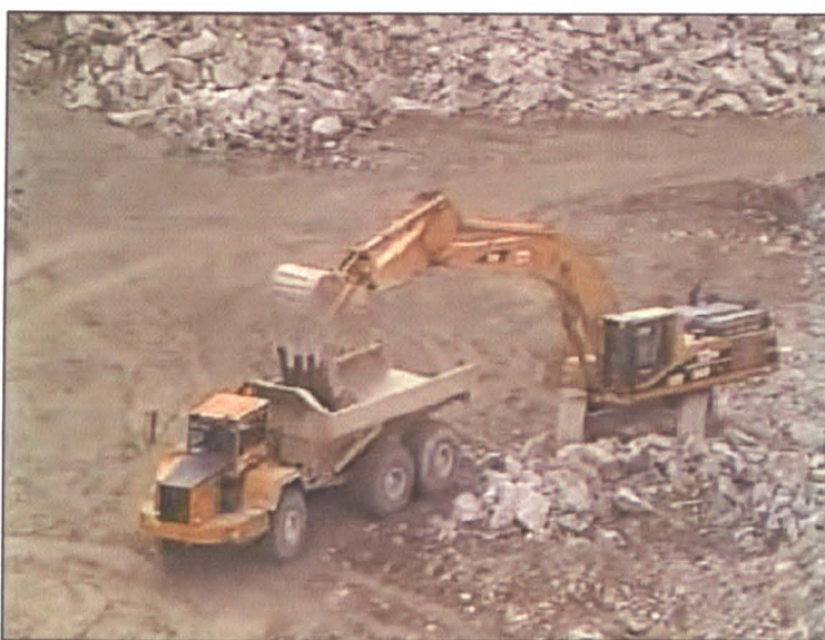
Foto 2- Carga de um dumper de 35 toneladas com retro - escavadora.
