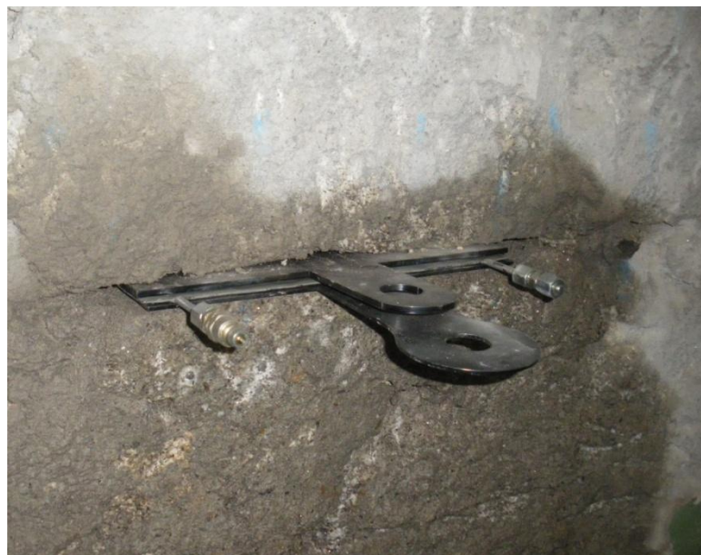
Fig.2.4 – Macaco Plano encaixado num rasgo de parede de Alvenaria de Pedra com a contribuição das chapas de espessura reduzida [10]
