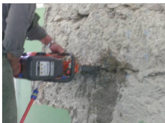
(b) Realização do corte com rebarbadora;
