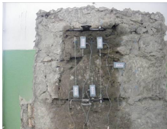
(b) Colocação dos macacos e dos LVDTs;
