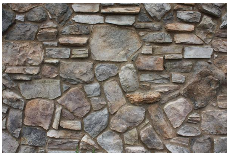
Fig.2.10 – Alvenaria de Pedra irregular.
