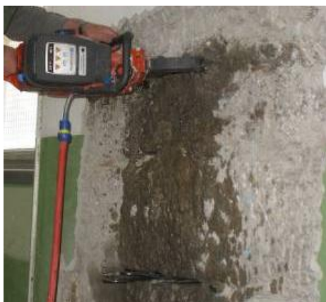
(a) Abertura do segundo rasgo;
