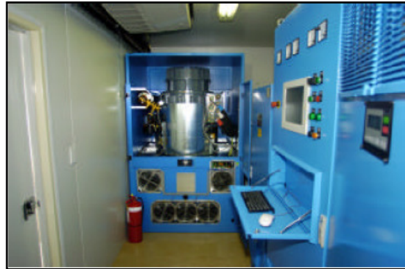
Figura 2.7 - Aspecto interior, volante de inércia PowerStore
