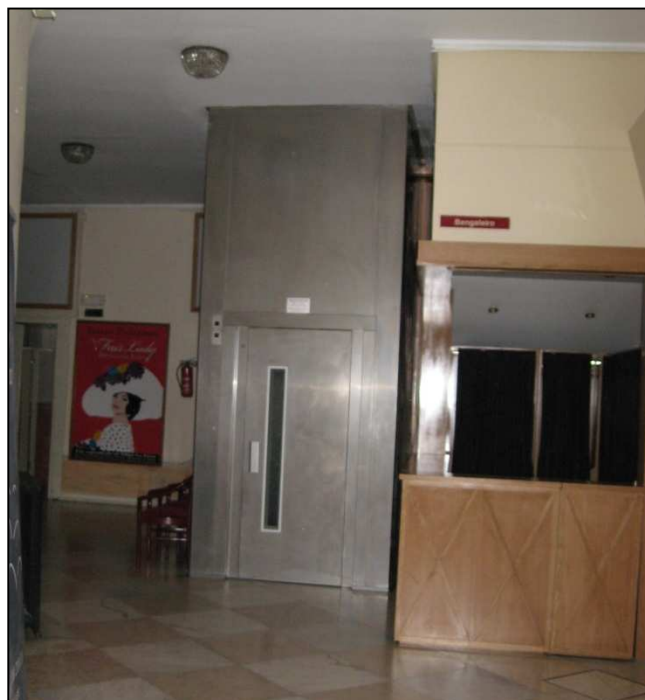
Fig. 4.5. – Caixa de elevador recentemente instalada, junto ao Bengaleiro
