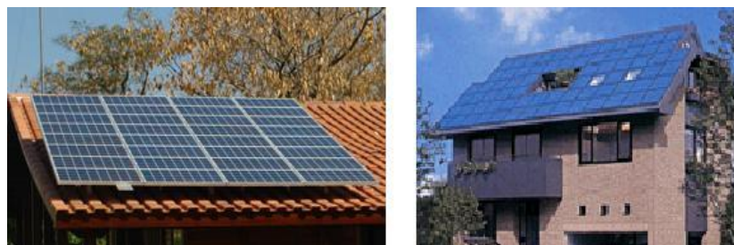
Figura 3.8 - Sistema montado no telhado inclinado (esquerda) e integrado no telhado inclinado (direita) [5]
