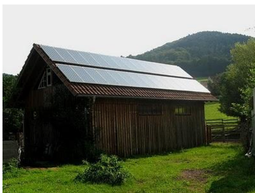
Figura 3.1 - Cabana com aproveitamento fotovoltaico [13]
