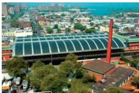
Figura 3.12 - Cobertura de vidro fotovoltaica [15]
