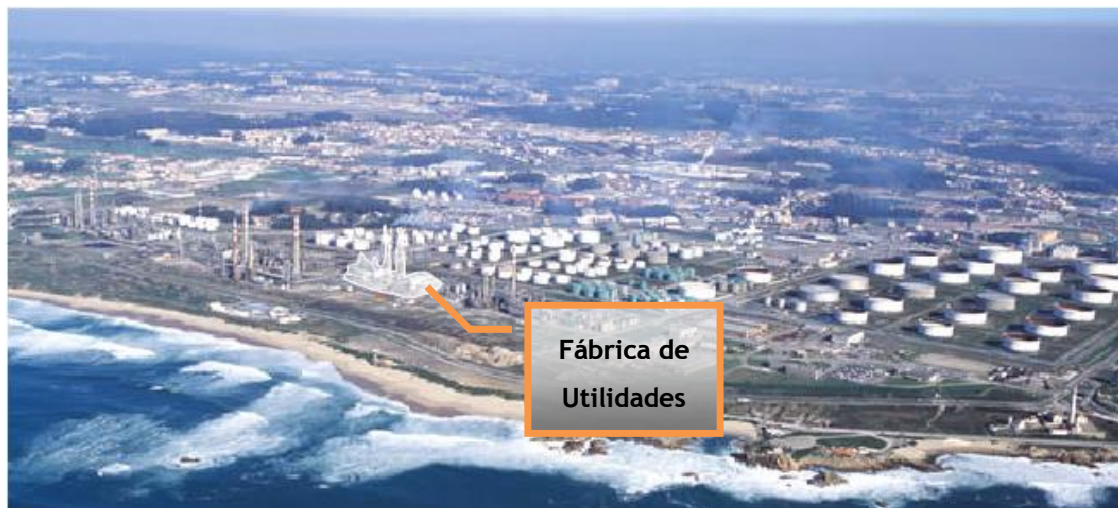
Figura 2.1 - Localização da Fábrica de Utilidades na Refinaria de Matosinhos [3]
