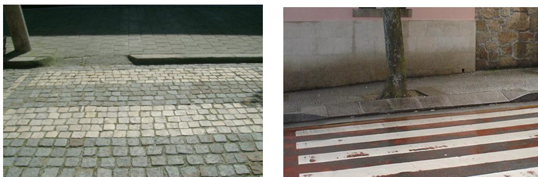
Fig. 3.27. – Travessias com condições para os peões de mobilidade condicionada
