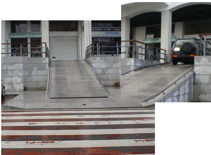
Fig. 3.30. – Acesso de entrada de garagem
