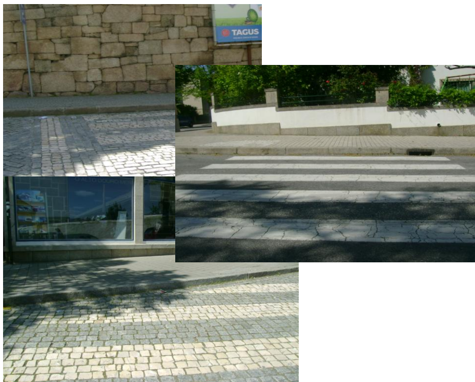
Fig. 3.26. – Travessias sem rampas
