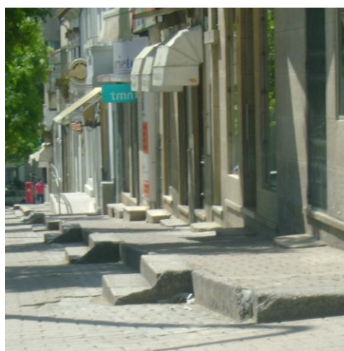
Fig. 3.20. – Passeio sem condições de acesso aos peões de mobilidade condicionada (zona 2d)
