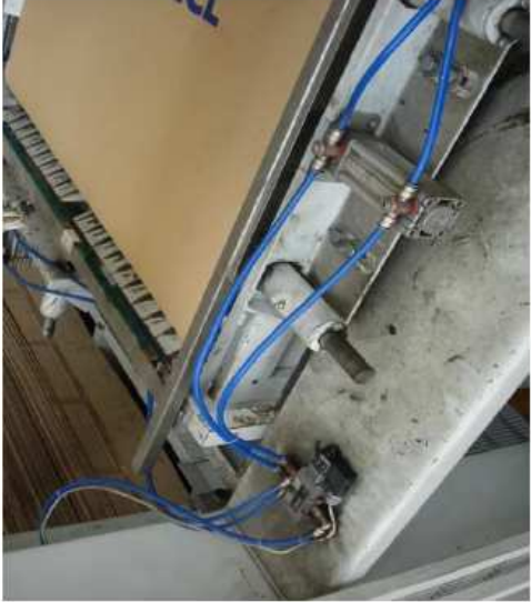
Fig. 30 - Inspeccionar fugas de ar
