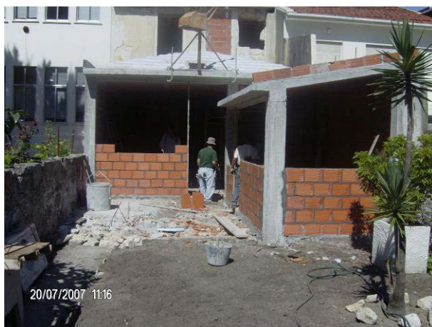
Fig.2 – Obra de ampliação
