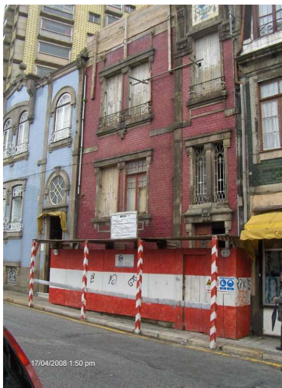
Fig.9 – Obra de reconstrução com preservação da fachada
