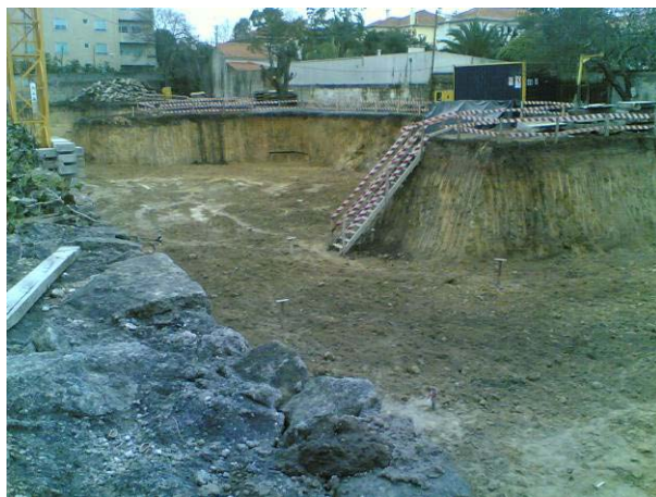
Fig.17 – Obra de escavação e contenção periférica
