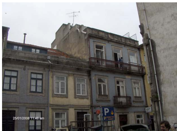
Fig.13 – Obras de alteração de caixilharia
