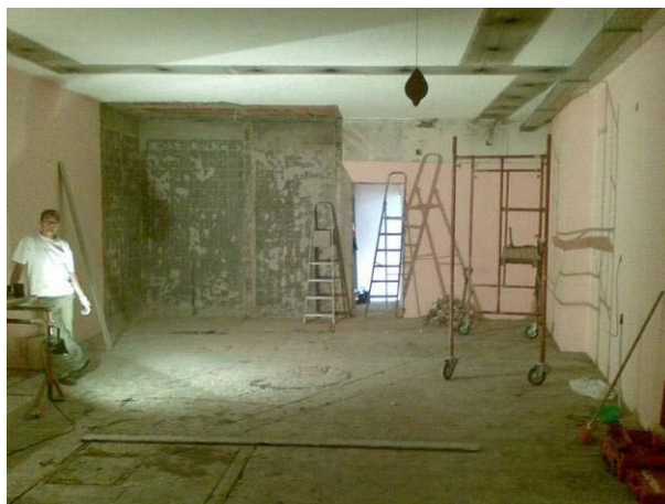
Fig.15 – Obras de alteração interior
