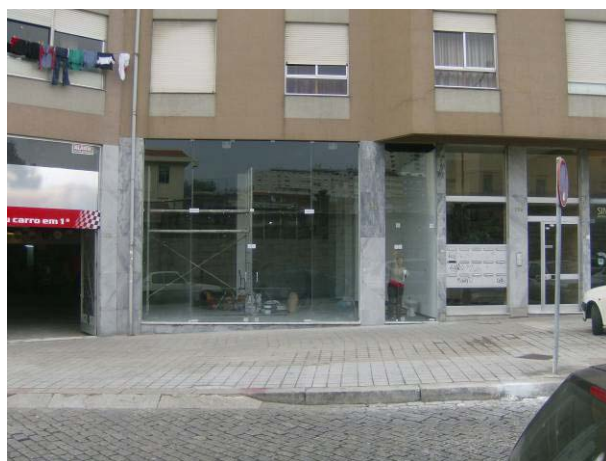
Fig.3 – Obra de alteração de fachada (vãos e caixilharia)
