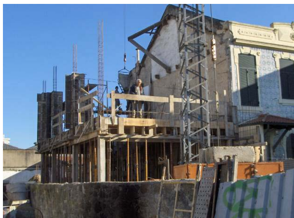
Fig.1 – Obra de reconstrução
