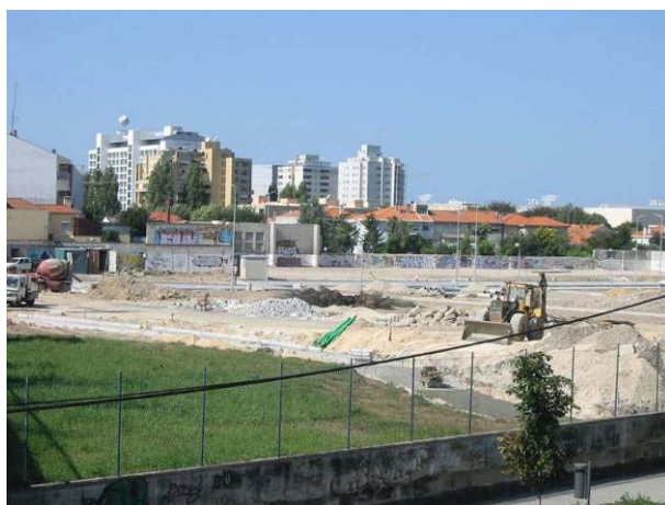
Fig.6 – Obras de urbanização
