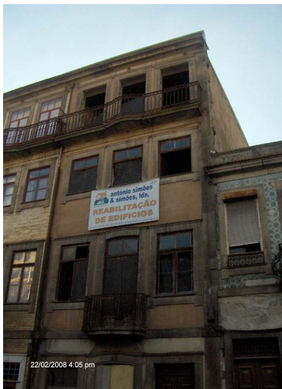
Fig.19 – Obras de conservação impostas pela DMSS
