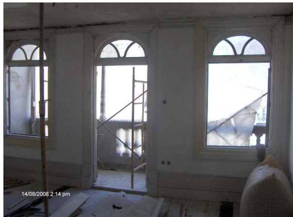
Fig.4 – Obras de Conservação interiores
