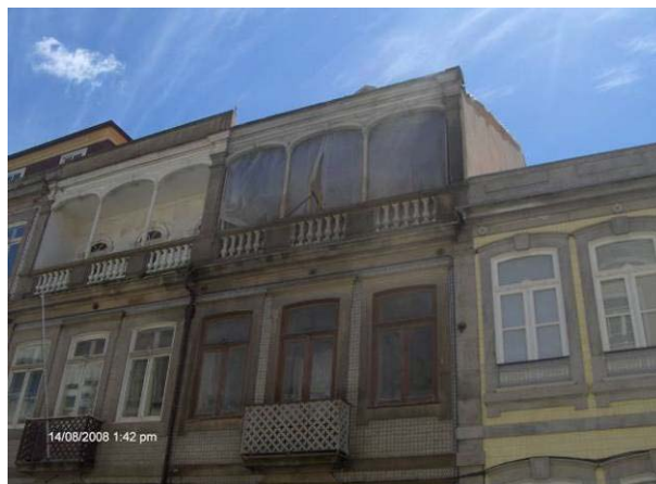
Fig.14 – Obras de conservação
