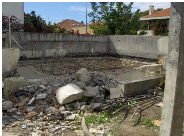
Fig.5 – Obra de demolição
