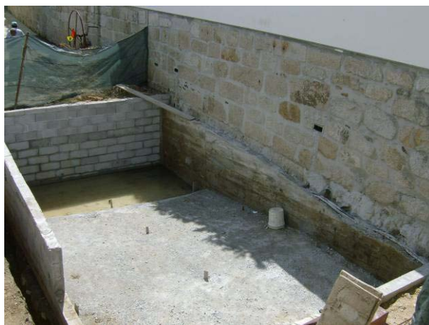
Fig.14 – Obra sujeita a comunicação prévia (piscina)
