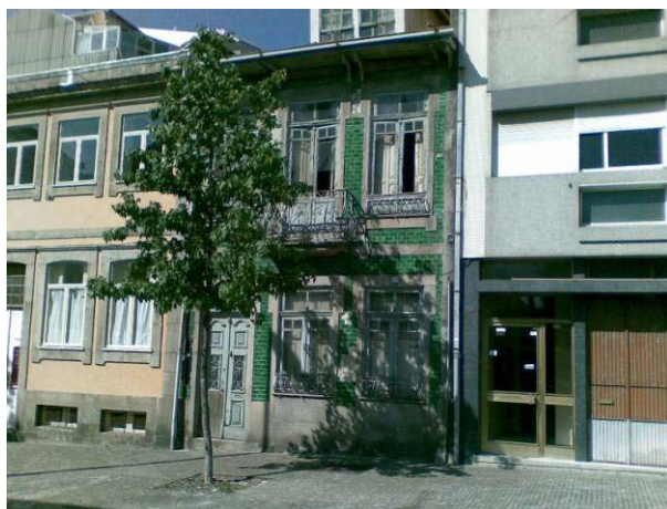
Fig.20 – Imóvel em fase avançada de degradação
