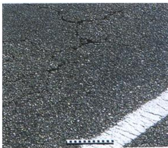
Foto 3.11 – Fendas de fadiga de classe 3 - CD
