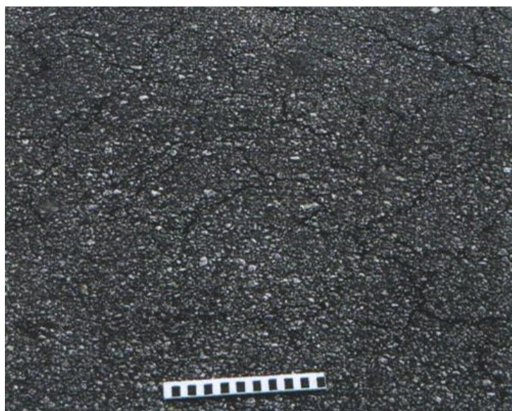
Foto 3.17 – Pele de crocodilo de malha estreita - CD
