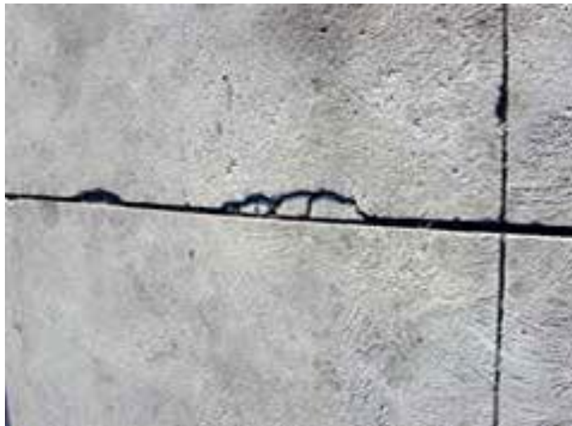
Foto 3.38 – Defeitos das juntas. Branco et al (2006)
