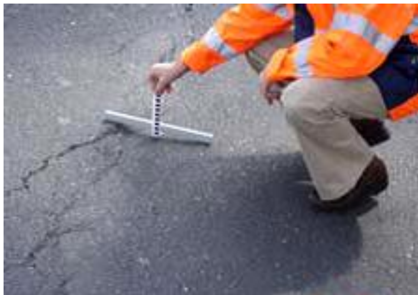
Foto 3.6 – Deformação localizada [7]
