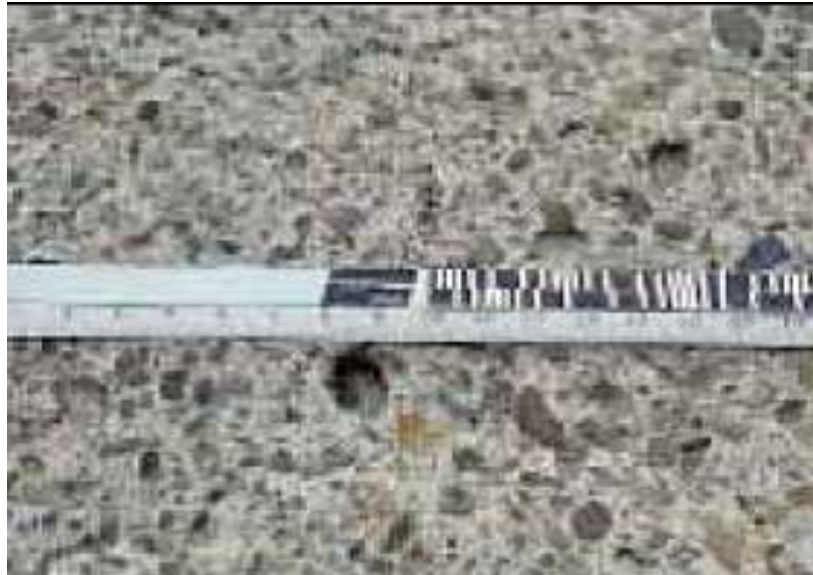
Foto 3.37 – Desagregação superficial. Branco et al (2006)
