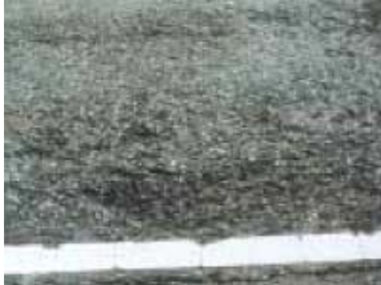
Foto 3.18 – Desagregação superficial [7]
