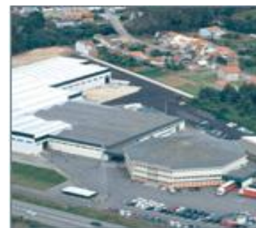
Figura 2 – Vista aérea da fábrica
