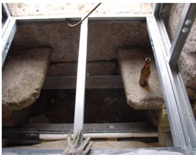
Foto 3.10 – Namoradeiras (bancos de pedra junto à janela)
