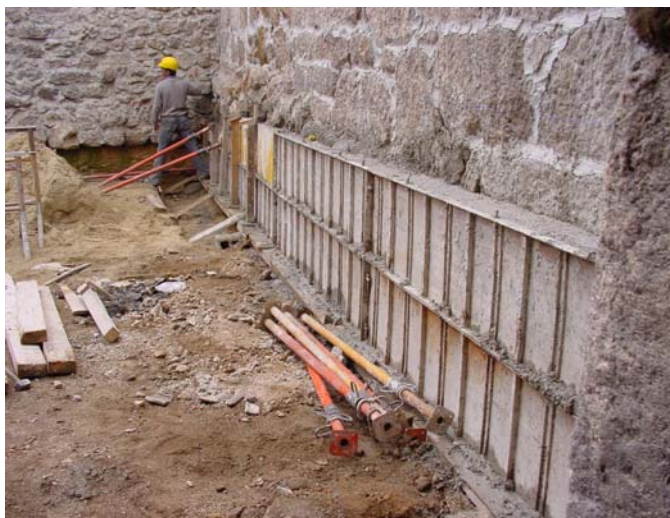
Foto 3.3 – Reforço de paredes em granito
