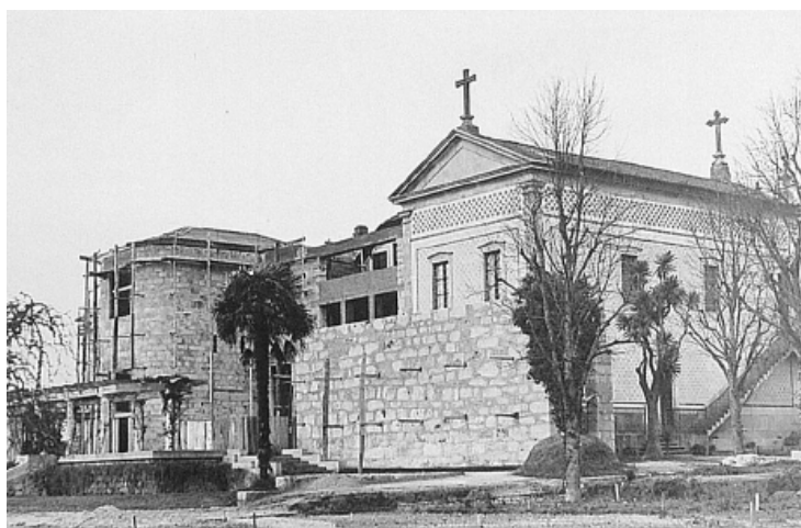
Foto 5.21 – Decorrer das obras de reconstrução e ampliação
