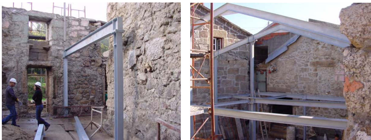
Foto 3.4 e Foto 3.5 – Colocação de perfis metálicos
