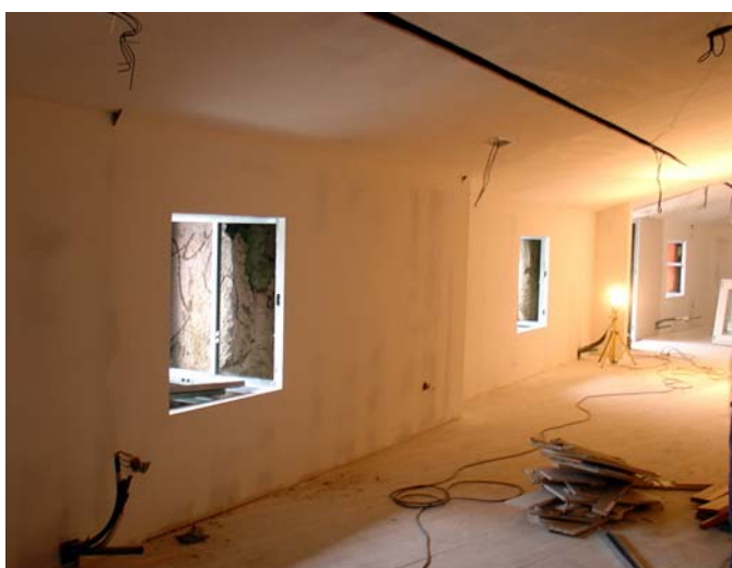
Foto 3.8 – Placas de gesso cartonado aplicadas no tecto e nas paredes
