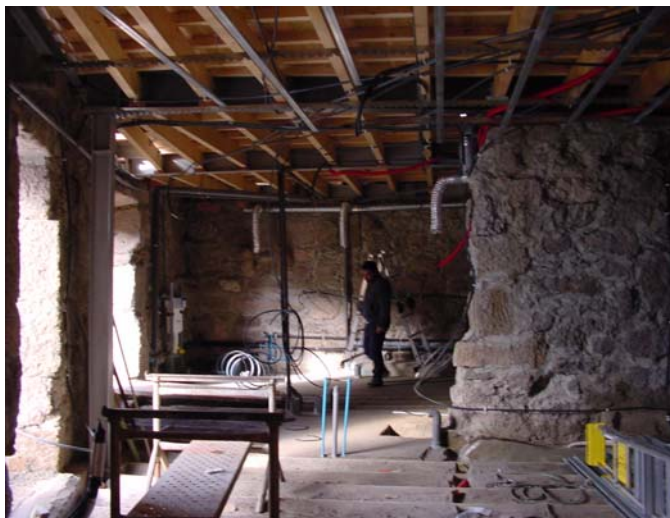
Foto 3.7 – Estrutura metálica de suporte do tecto suspenso, em gesso cartonado
