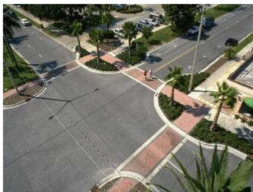
Fig.3.2 – Estrangulamento das entradas das intersecções (fonte: http://www.pps.org/topics/wtc_site/test )
