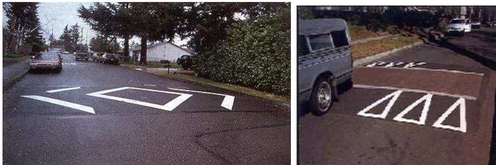
Fig.3.12 – Lombas: longa, trapezoidal (fonte: apontamentos da disciplina de circulação e transporte 2 FEUP)
