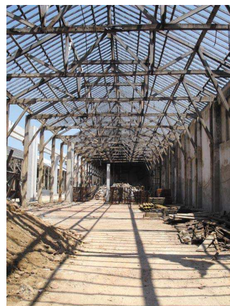
Figura 2.12. – Cobertura de madeira. [93]
