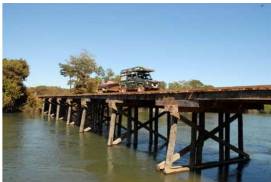
Figura 2.11. – Ponte de madeira. [92]
