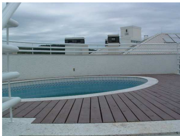
Figura 2.6. – Pavimento de Madeira junto a Piscina. [57]
