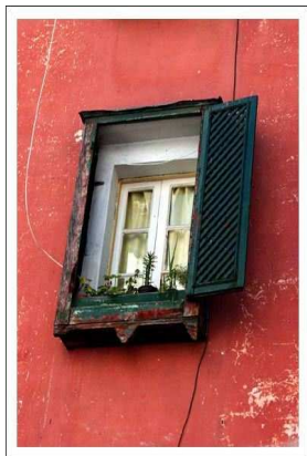
Figura 2.7. – Janela e Portadas de Madeira. [89]
