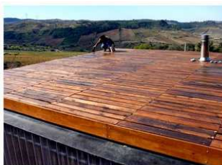
Figura 3.1. – Cobertura com acabamento de velatura. [86]
