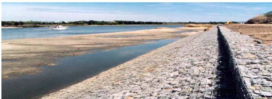
Figura 4.29 - Colchões Reno aplicados numa estrutura de protecção fluvial (Brasil) [17].
