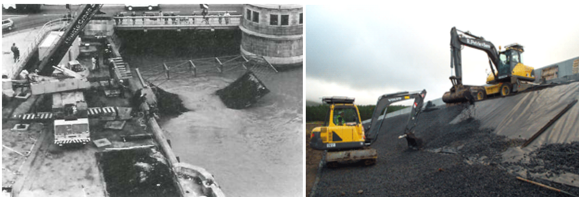
Figura 4.37 - Aplicação subaquática de uma manta OSA pré-fabricada (esquerda) (Reino Unido) e execução a seco de um revestimento OSA, na fase de preparação do mastic (direita) (Alemanha) [11].
