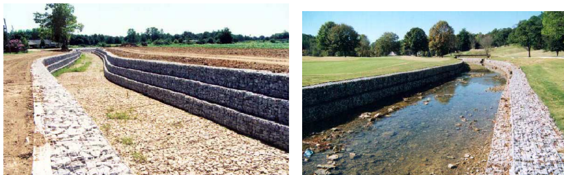
Figura 4.13 - Estrutura de gabiões.
