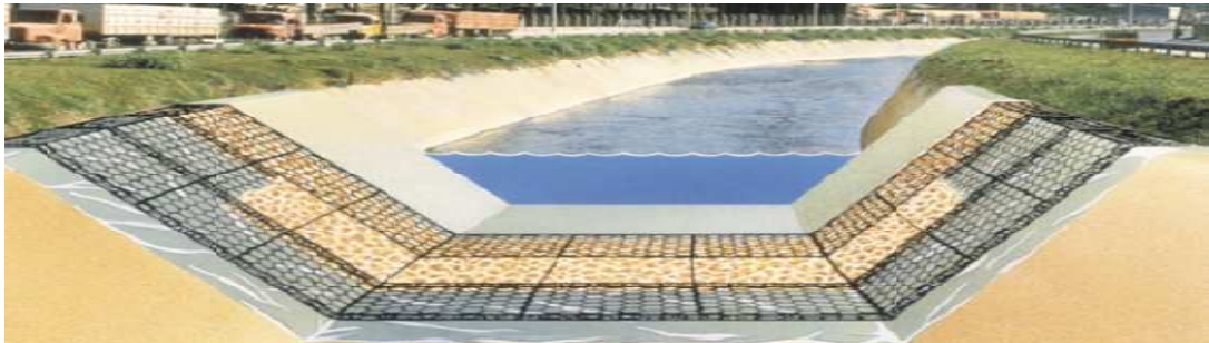
Figura 4.32 - Canal fluvial revestido com colchões Reno (Brasil) [17].
