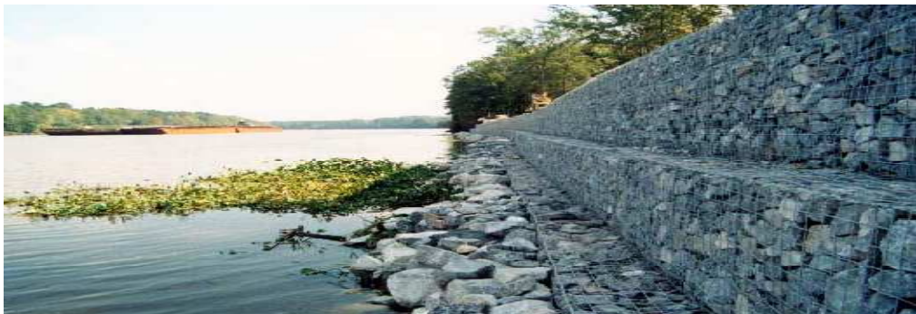
Figura 4.22 - Gabiões caixa aplicados numa estrutura de protecção fluvial (Brasil) [17].
