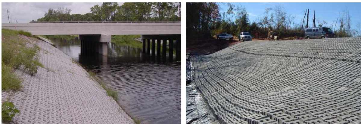
Figura 4.34 - Exemplos de revestimentos com blocos pré-fabricados unidos.
