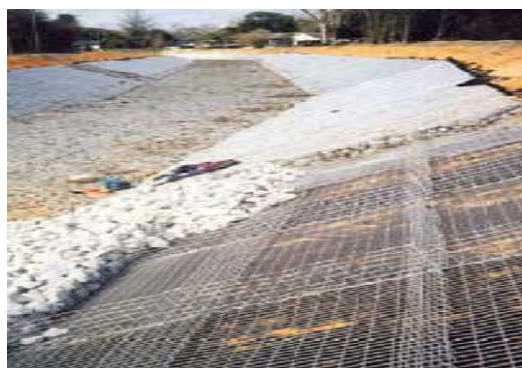
Figura 4.31 - Processo de enchimento dos colchões Reno (França) [17].
