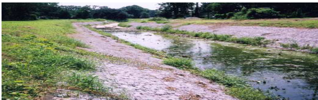
Figura 4.30 - Colchões Reno aplicados numa estrutura de protecção fluvial (Bolívia) [17].
