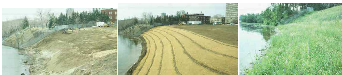
Figura 4.54 - Preparação do terreno ao longo da margem para a instalação da técnica de bioengenharia adequada (esquerda). Colocação das fachinas em diversas faixas devidamente distanciadas, ao longo das margens (centro). Margem protegida com vegetação (direita) [18].
