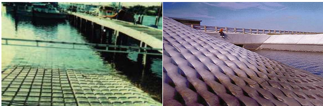
Figura 4.36 - Revestimentos com blocos de betão pré fabricados unidos (EUA) [18].
