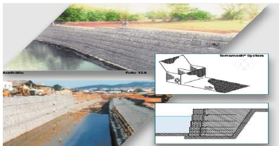
Figura 4.15 - Aplicação de gabiões em protecções longitudinais.
