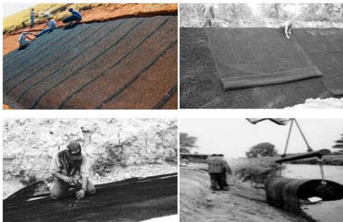
Figura 4.40 - Instalação de geomantas [17].
