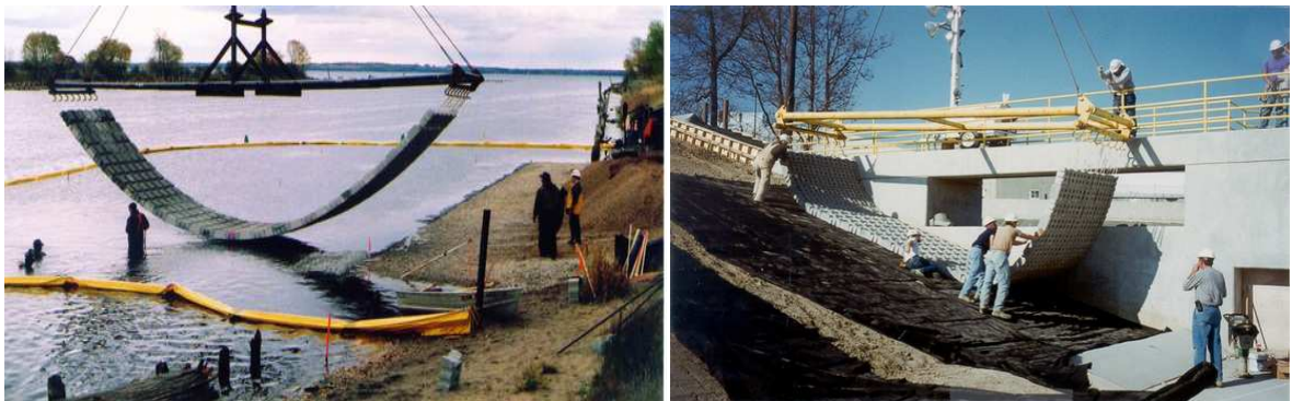
Figura 4.35 - Exemplos de aplicação de blocos pré-fabricados unidos (EUA) [18].
