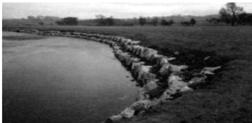
Figura 4.7 - Exemplo de uma protecção com blocos de pedra.
