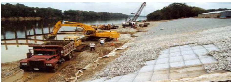
Figura 4.28 - Colchões Reno aplicados numa estrutura de protecção fluvial (Brasil) [17].
