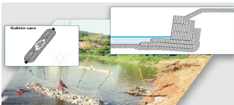
Figura 4.26 - Aplicação do gabião saco numa estrutura de protecção (Brasil) [17].
