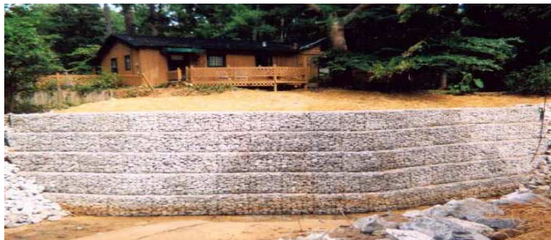
Figura 4.12 - Estrutura de gabiões, edificada como muro de contenção de terras e protecção fluvial.
