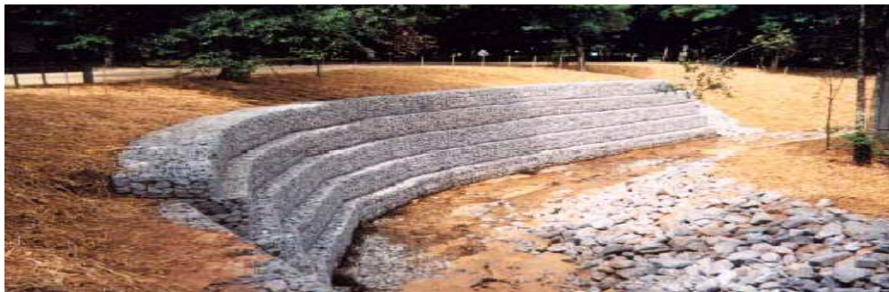
Figura 4.23 - Gabiões caixa aplicados numa estrutura de protecção fluvial (EUA) [17].
