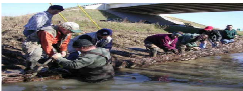
Figura 4.50 - Construção de uma protecção com fachinas [10].
