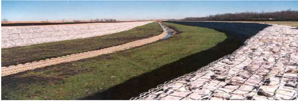
Figura 4.21 - Gabiões caixa aplicados numa estrutura de protecção fluvial (Alemanha) [17].
