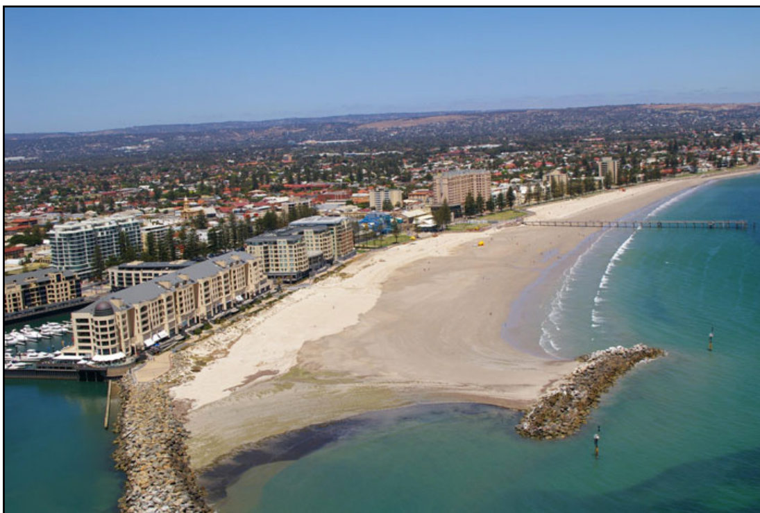
Figura 2.19 – Quebramar destacado sujeito a agitação média/calma, com formação de tómbolo (Adelaide, Austrália).
