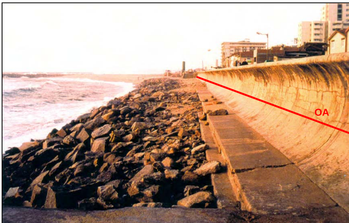
Figura 4.14 – Obra longitudinal aderente da frente litoral da cidade de Espinho (Dias, A., 1994).
