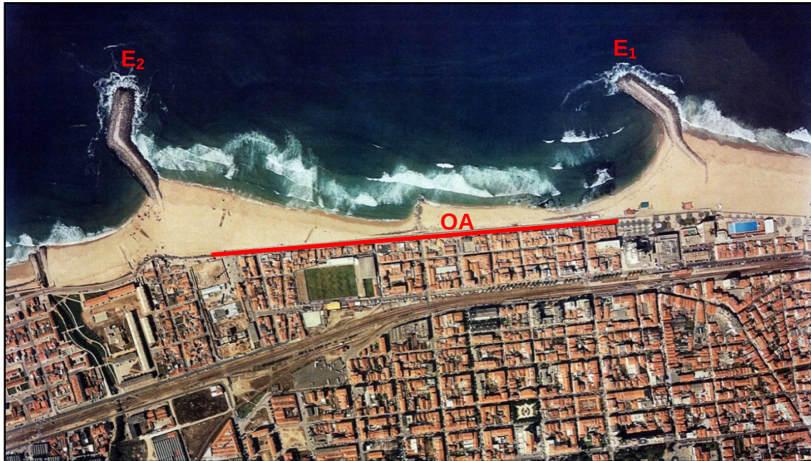
Figura 4.13 – Esporões norte e sul da frente litoral da cidade de Espinho (EUrosion, 2006).
