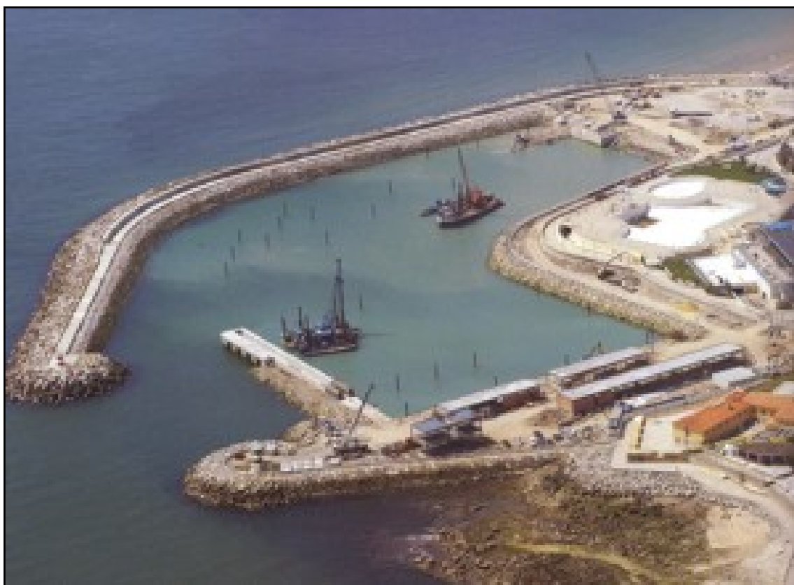
Figura 2.13 – Quebramares de Taludes do Porto de Recreio de Oeiras, Portugal.
