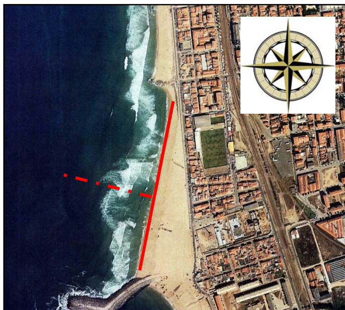
Figura 4.26 – Orientação perpendicular a WNW, da linha de praia junto ao esporão sul.
