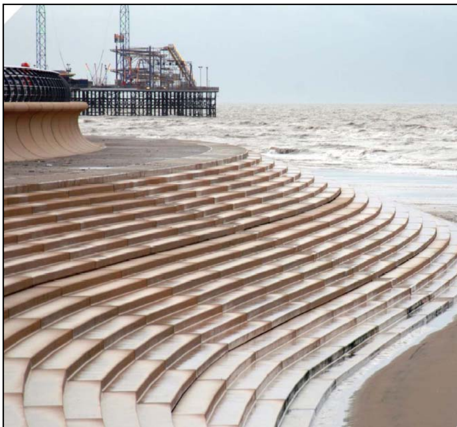
Figura 2.15 – Obra longitudinal aderente.
