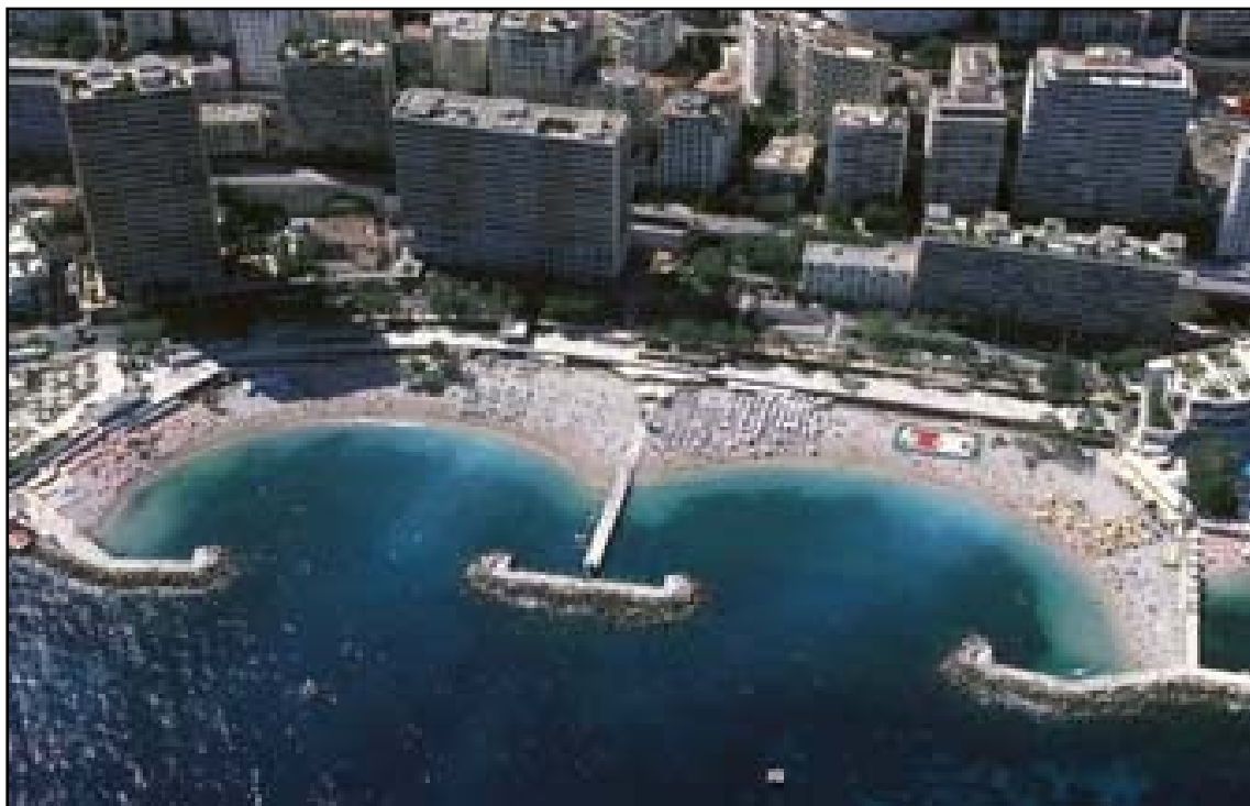
Figura 2.20 – Quebramar destacado sujeito a agitação calma, com formação de saliência (Monte Carlo, Mónaco).
