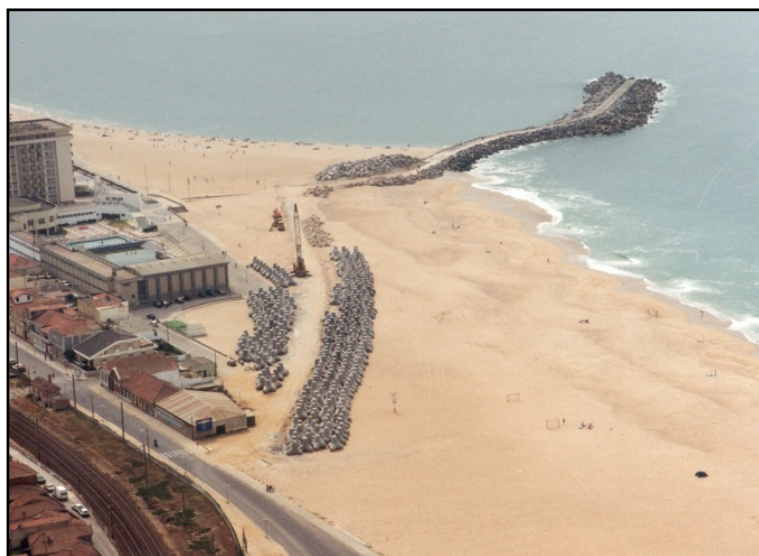
Figura 4.11 – Construção do esporão norte, 1997.
