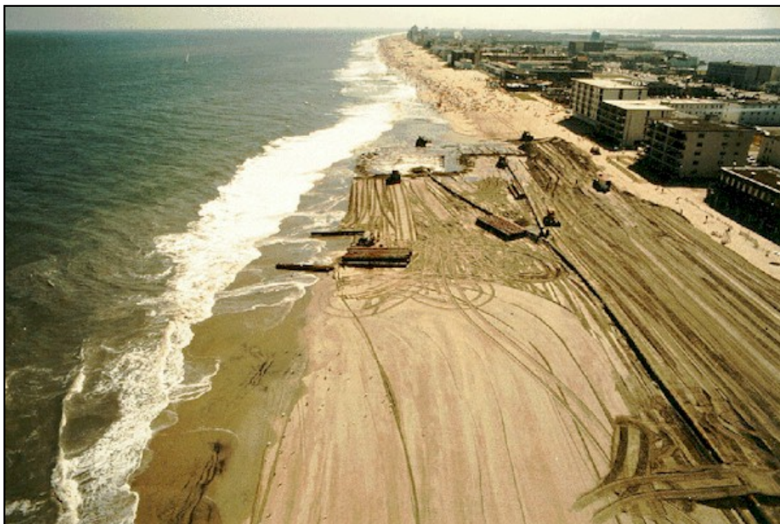
Figura 2.12 – Alimentação artificial da praia de New Jersey, EUA.
