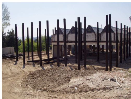
Fig. 6.18 – Perspectiva após colocação dos pilares
