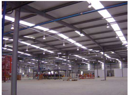
Fig. 6.27 – Unidade industrial em fase de conclusão
