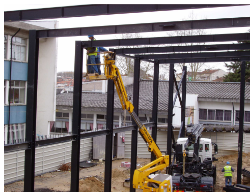
Fig. 6.19 – Montagem com aparafusamento
