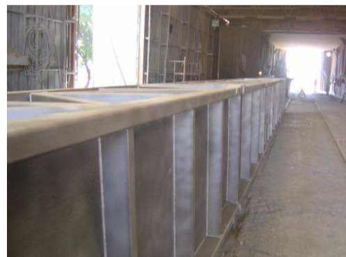
Fig. 4.34 – Peça metalizada a quente após decapagem com jacto de granalha de aço
