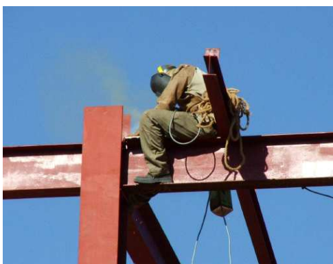
Fig. 4.41 – Soldaduras em obra [45]
