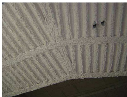
Fig. 6.25 – Parte da estrutura já revestida com argamassa intumescente
