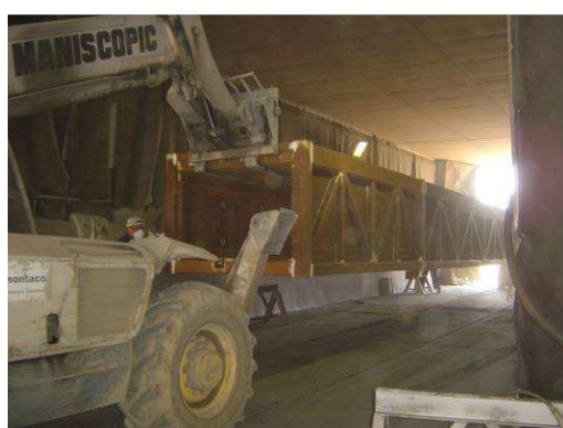
Fig. 4.29 – Cabine de decapagem
