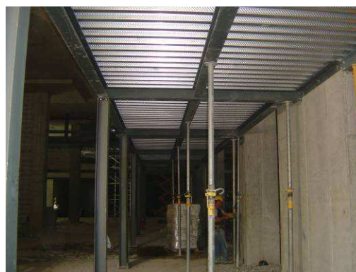
Fig. 6.23 – Estrutura metálica colocada
