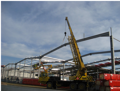
Fig. 6.26 – Montagem de um pórtico
