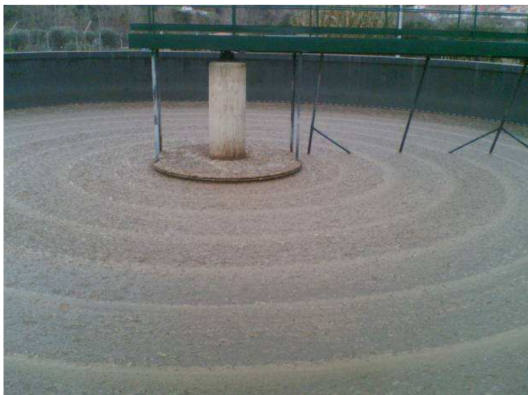
Figura B 2. Decantador secundário (8 de Janeiro de 2007).
