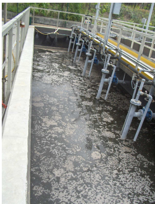
Figura 5. Decantador da ETAR de S. Miguel de Lobrigos
