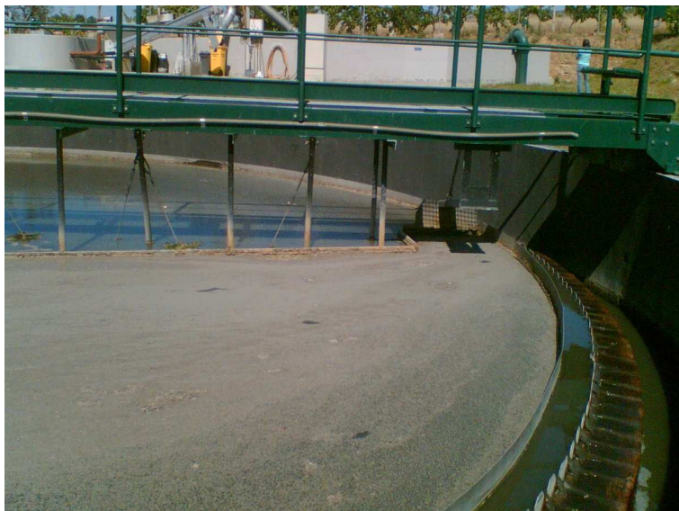
Figura B 1. Decantador primário após a limpeza do emissário (29 de Junho de 2007).
