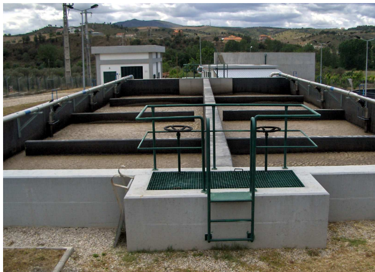
Figura 15. Tanques de arejamento da ETAR de Mirandela.
