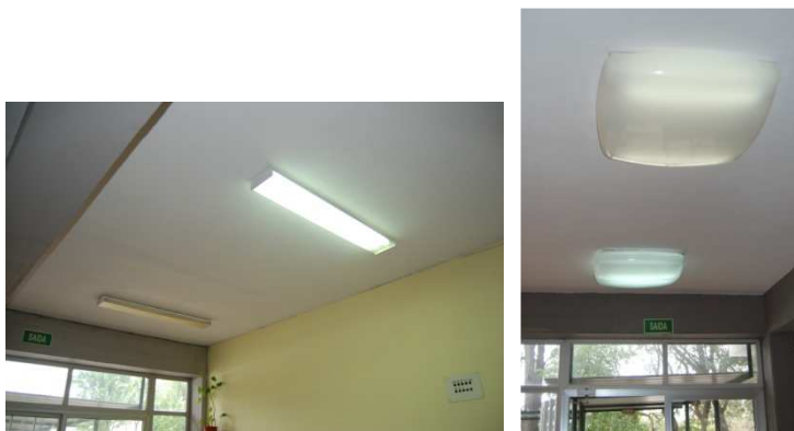
Figura 5.6 - Luminárias tipo, dos corredores das escolas do modelo M2.
