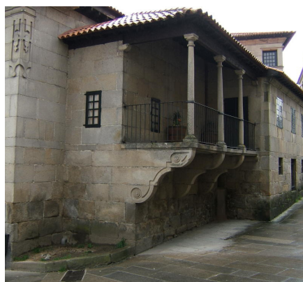
Fig.17 – Habitação em alvenaria de pedra
