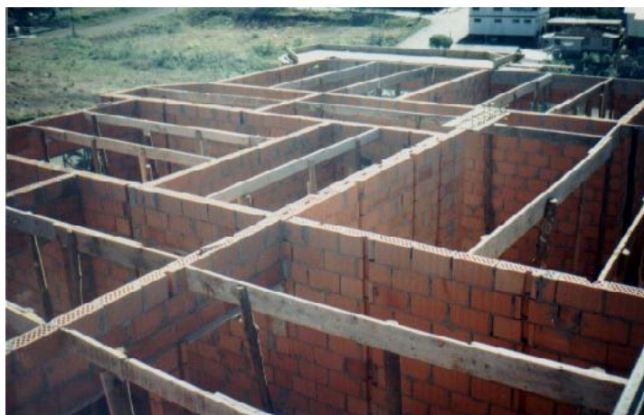
Fig.6 – Construção em alvenaria estrutural
