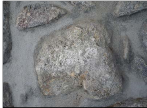
Figura 4.9 – Eflorescências na parede de alvenaria (alçado Norte) – Termas de Caldelas
