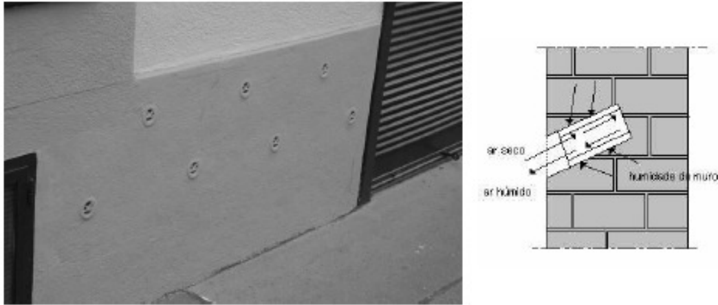
Figura 4.5 – Tubos de Knappen (Freitas e Gonçalves, 2003)
