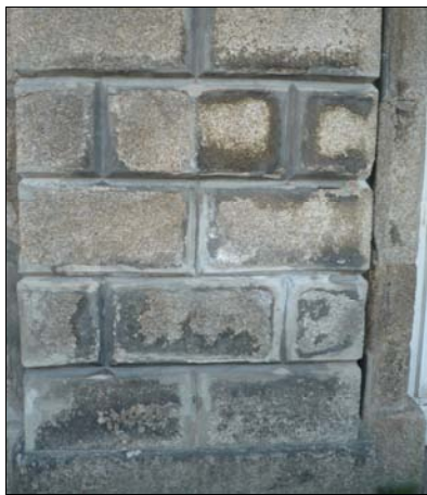
Figura 4.10- Desagregação granular associada a eflorescências na Fachada Este do Hospital de Santo António
