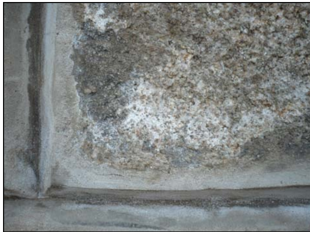
Figura 4.10- Desagregação granular associada a eflorescências na Fachada Este do Hospital de Santo António
