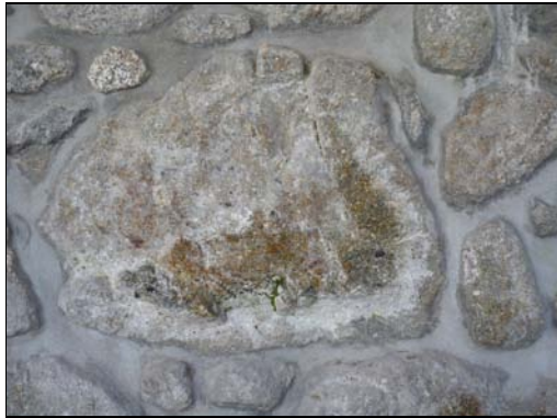
Figura 4.9 – Eflorescências na parede de alvenaria (alçado Norte) – Termas de Caldelas
