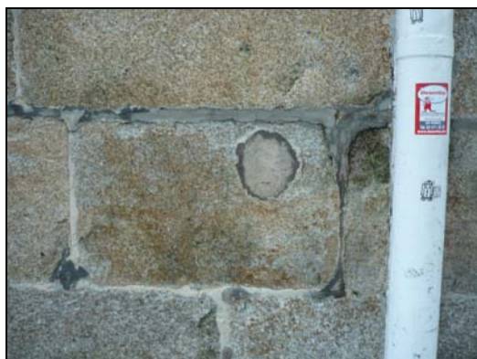
Figura 4.13 – Plaquetas “reparadas” com argamassa de cimento (Rua da Lapa, Quartel – General do Porto)
