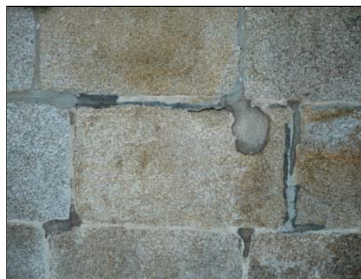
Figura 4.13 – Plaquetas “reparadas” com argamassa de cimento (Rua da Lapa, Quartel – General do Porto)
