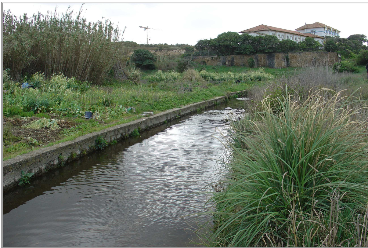
Figura 5.39 – Local de determinação dos valores de escoamento (foz da Ribeira de Valadares)
