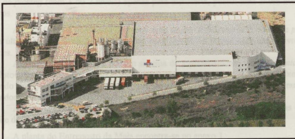
Fig. 6 - Vista panorâmica do Centro de Distribuição da Maia
