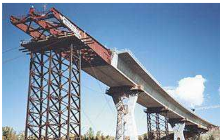
Fig. 2.25 – Exemplo de construção com pilares provisórios [19]
