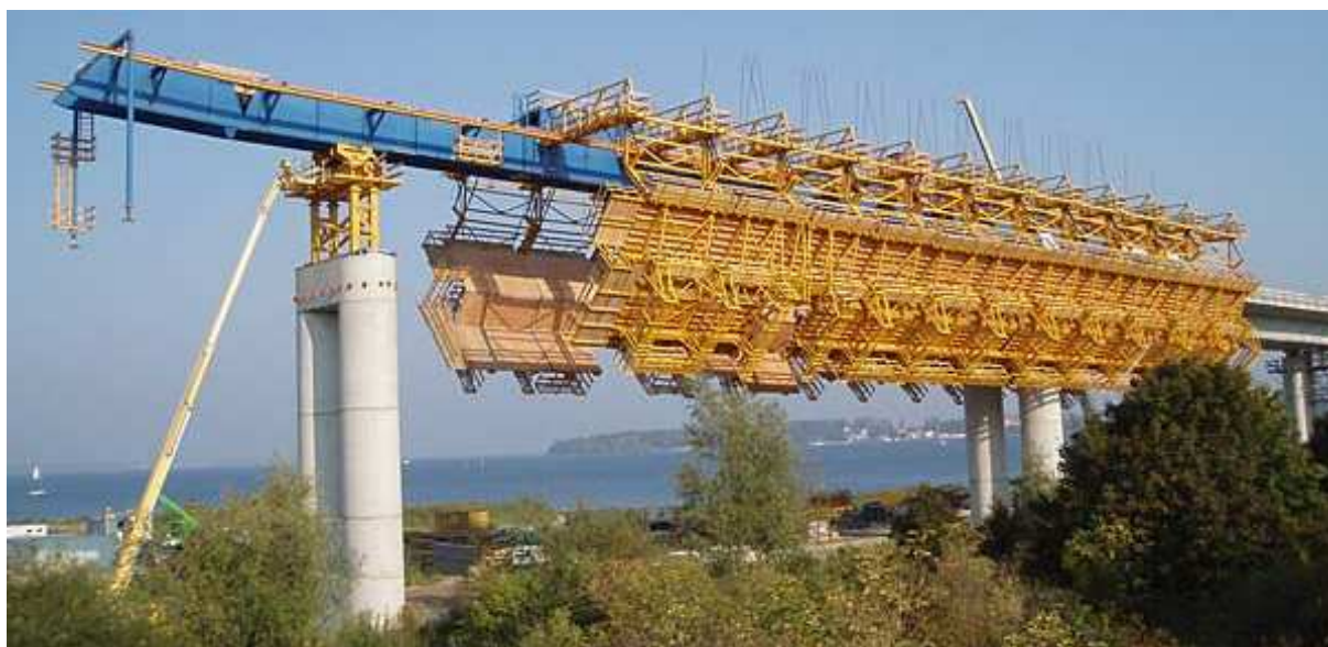
Fig. 2.6 – Exemplo de um cimbra superior em fase de lançamento [10]
