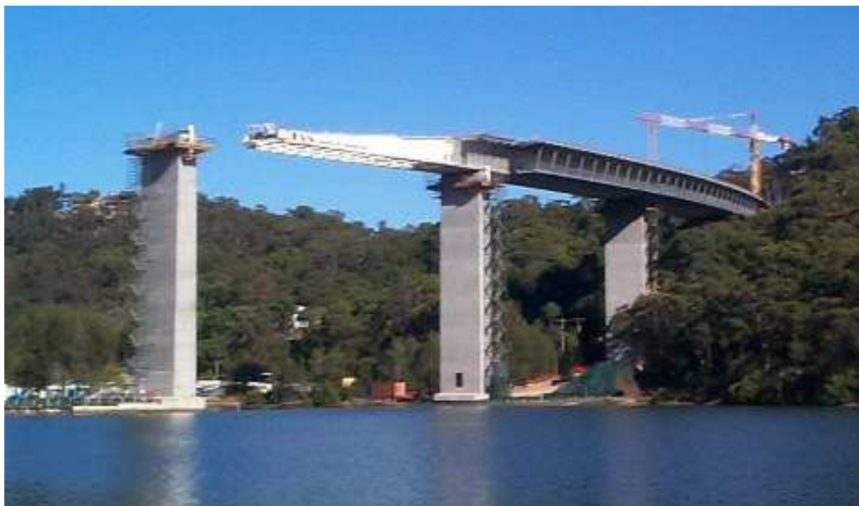
Fig. 2.21 – Construção por lançamento incremental [15]
