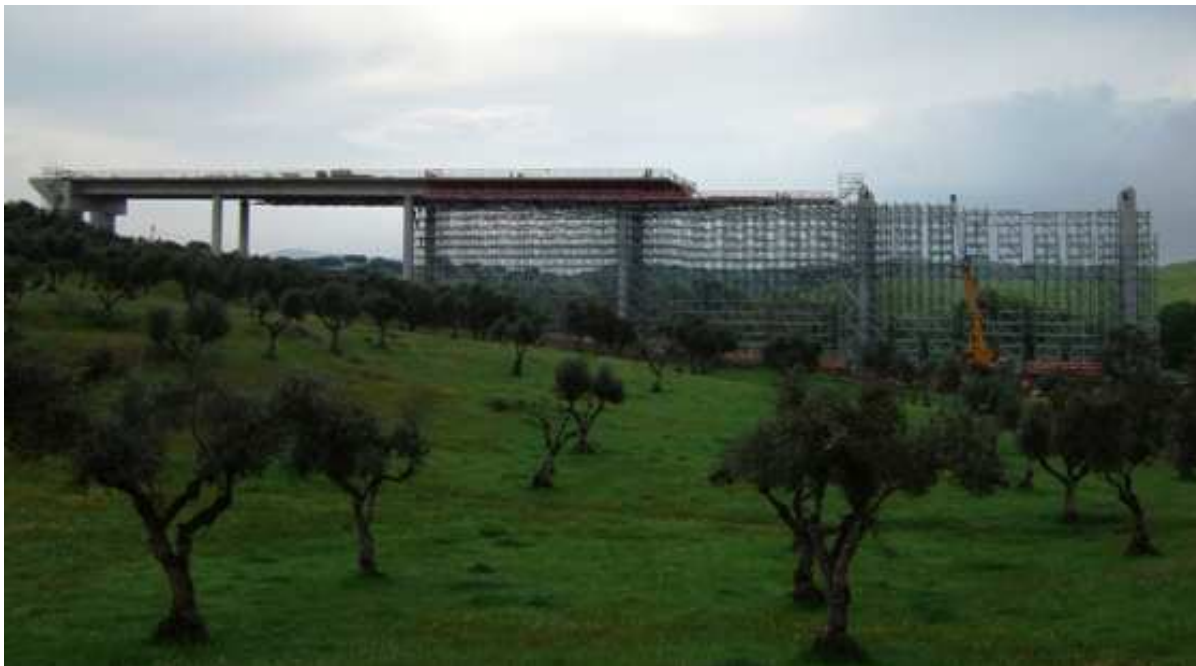
Fig. 2.1 – Cimbra ao solo (Viadutos do Seda e Chocanal IC–13 Alter do Chão/ Portalegre) [6]
