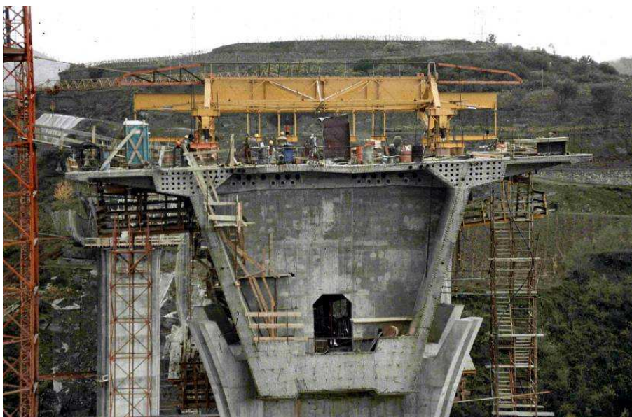
Fig. 2.13 – Aduela zero (Ponte Miguel Torga)
