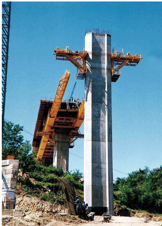
Fig. 2.9 – Consolas de apoio fixas ao pilar [10]
