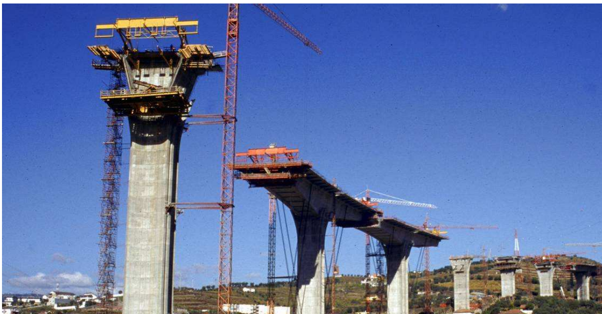
Fig. 2.12 – Construção por avanços sucessivos (Ponte Miguel Torga)
