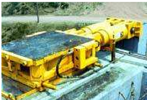
Fig. 2.23 – Cilindros hidráulicos para empurre do tabuleiro [17]
