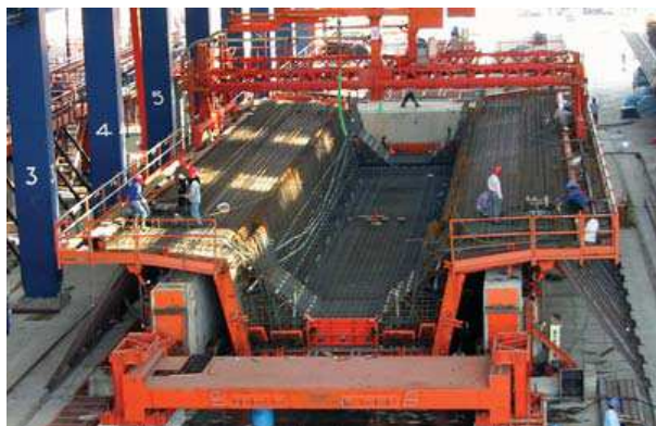
Fig. 2.22 – “Fábrica” de construção do tabuleiro (Taiwan High Speed Rail C215)
