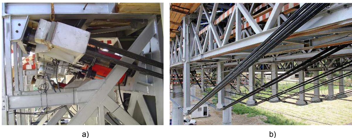
Fig. 2.30 – a) Ancoragem Orgânica e actuador. b) Cabos e escoras de desvio na posição de betonagem [3]
