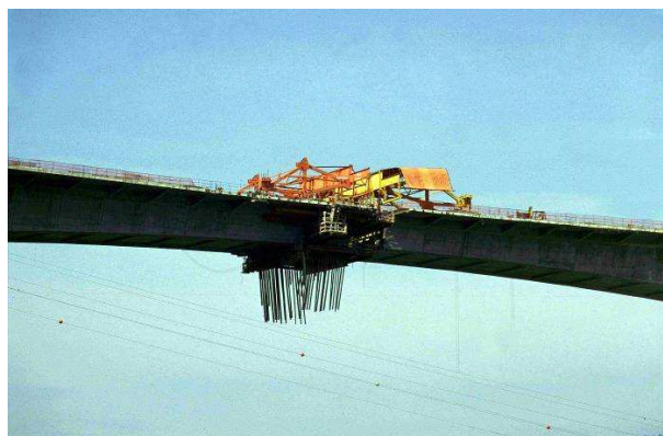
Fig. 2.16 – Construção da aduela de fecho (Ponte Miguel Torga)
