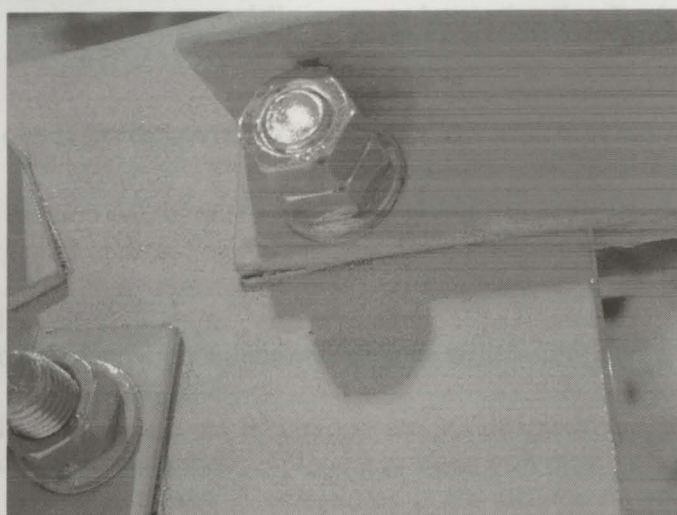
Figura 19 – Materialização de um nó rotulado através da introdução de uma segunda porca
