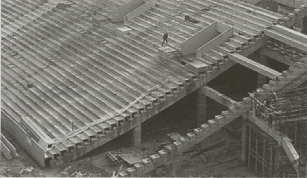
Figura 15 – Colocação dos degraus de bancada no estádio Euro Antas
