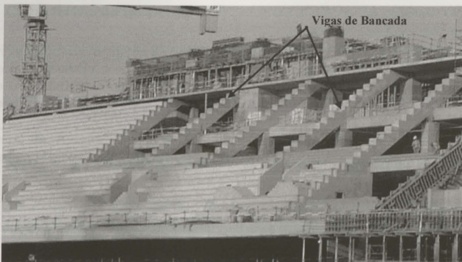
Figura 13 – Construção das bancadas do Estádio do Dragão, numa fase em que são
