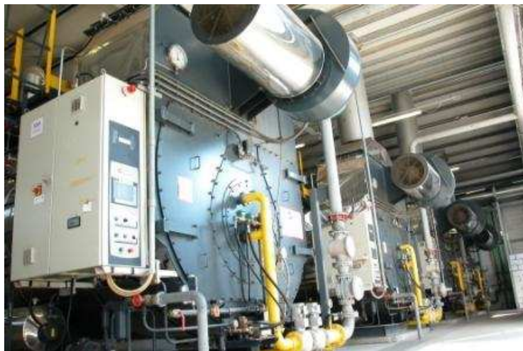
Figura 16. Caldeira Flamotubular.
