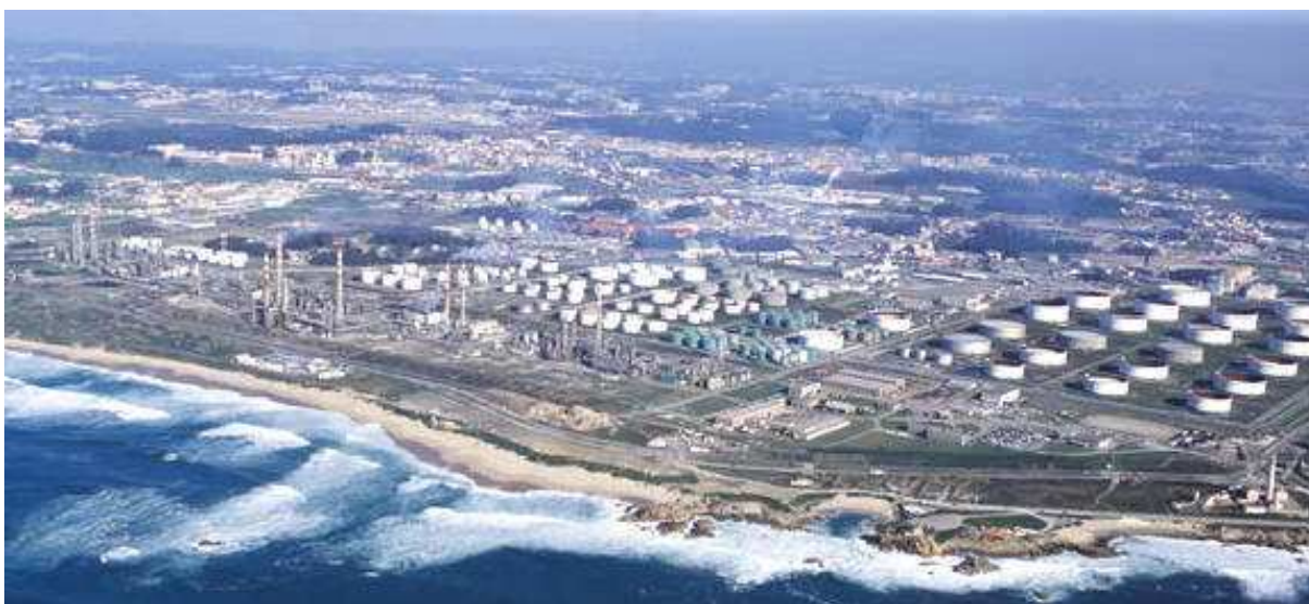
Figura 1. Vista panorâmica da Refinaria do Porto da Petrogal.
