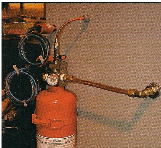
Figura 4.11 – Firetrace de actuação indirecta
