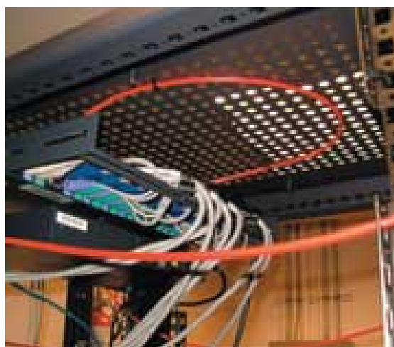
Figura 4.8 – Pormenor de tubo de detecção Firetrace
