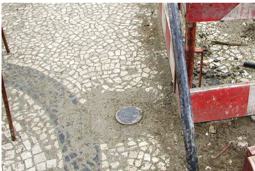
Figura 4.7 – Exemplo de uma marca topográfica situada à superfície.
