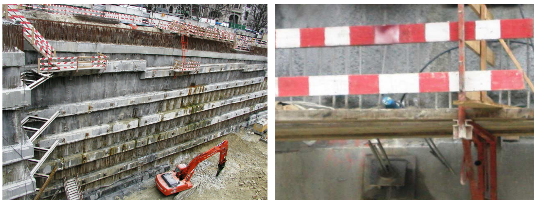
Figura 4.5 – Disposição dos inclinómetros horizontais (IH1 e IH2), à esquerda, com pormenor do IH2, à direita.
