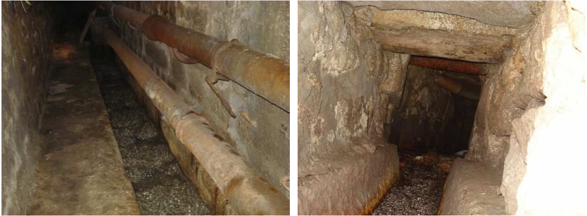
Figura 2.7 – Imagens do “Rio da Vila” que passa sob a Avenida dos Aliados, ( http://www.ribeirasdoporto.pt ).
