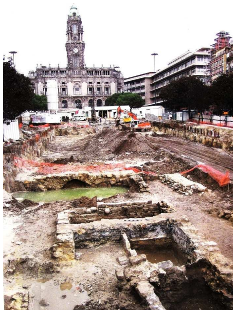
Figura 2.4 – Pormenor das infra-estruturas existentes no início da escavação (Morgado et al. , 2007).
