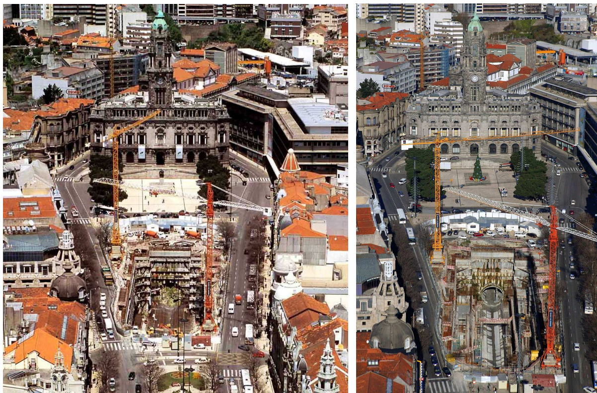
Figura 2.3 – Zona de implantação da estação inserida no meio urbano, durante a construção (©F. Piqueiro/Foto Engenho, Lda, 2003).
