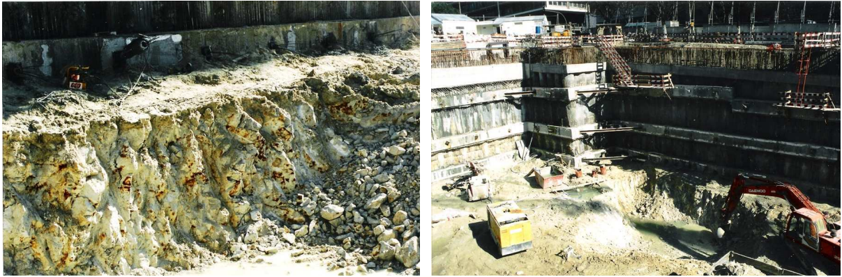
Figura 2.12 – Sobre-escavação à cota 56.50 m, (fotografias de Viana da Fonseca, 2003).
