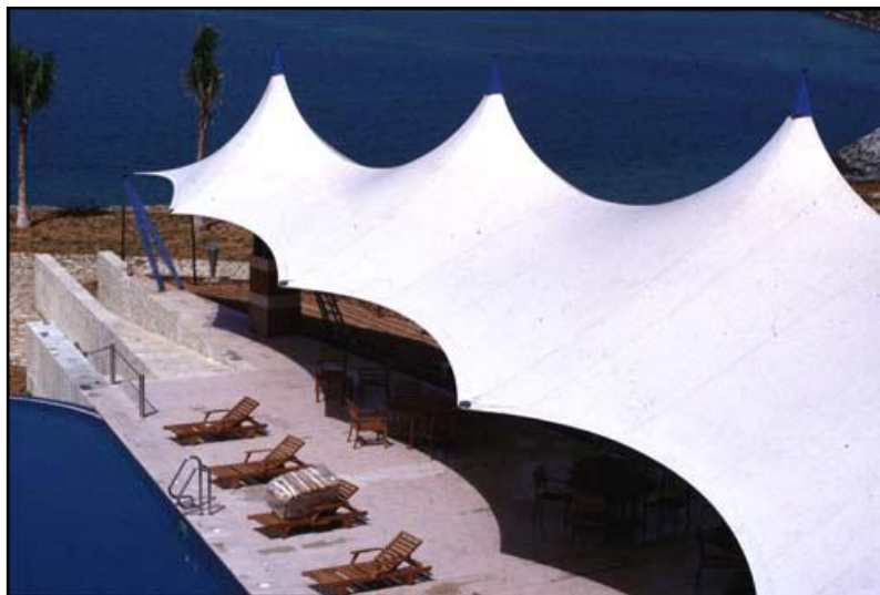
Fig.3.39. – Cobertura de um espaço privado – Dubai, Emirados Árabes Unidos
