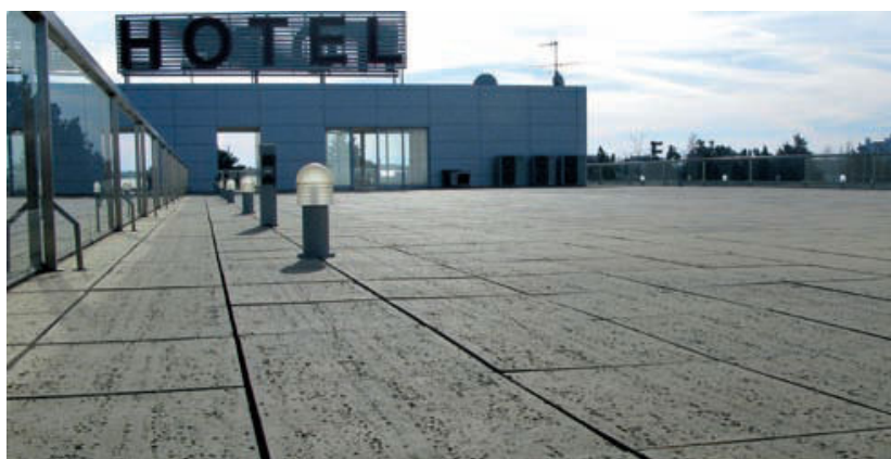
Figura 4.10 – Lajetas pré-fabricadas em cobertura plana [22].
