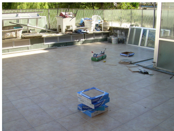
Figura 4.7 – Revestimento cerâmico em cobertura plana.
