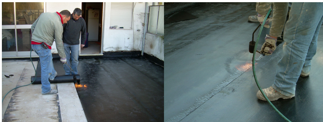
Figura 4.2 – Execução de juntas de sobreposição.
