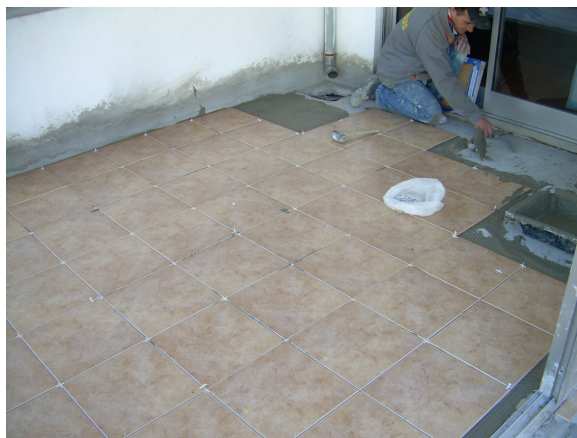
Figura 4.8 – Assentamento de ladrilhos cerâmicos.
