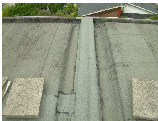
Figura 5.18 – Remate em junta de dilatação
