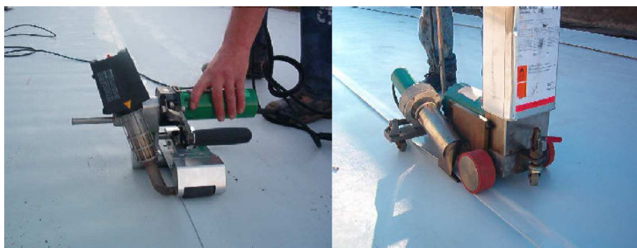
Figura 4.4 – Soldadura a ar quente de membranas de PVC [15].
