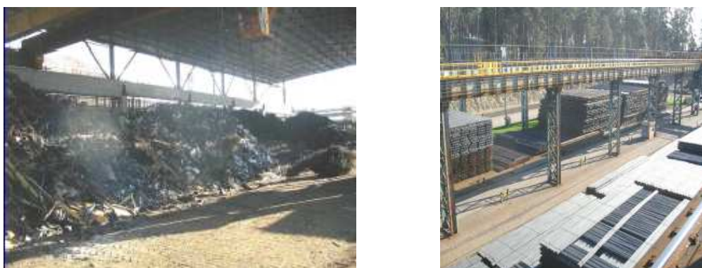
Figura 23 - Parque de armazenamento da sucata (esquerda) e do produto final (direita).
