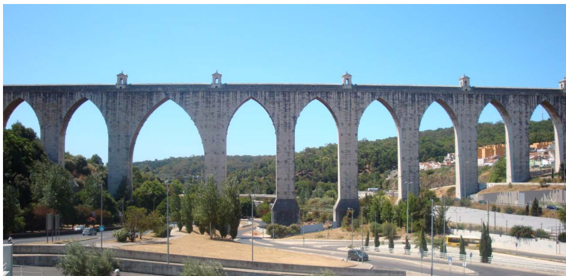
Fig. 2-15 – Aqeduto das Águas Livres, Lisboa
