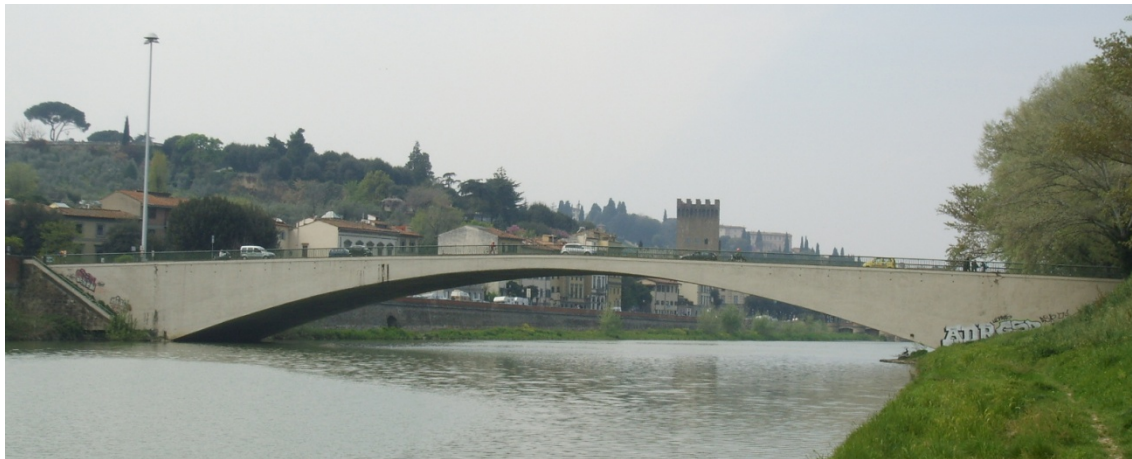
Fig. 2-33 – Ponte di San Niccolò – Florença (1944), arco tímpano
