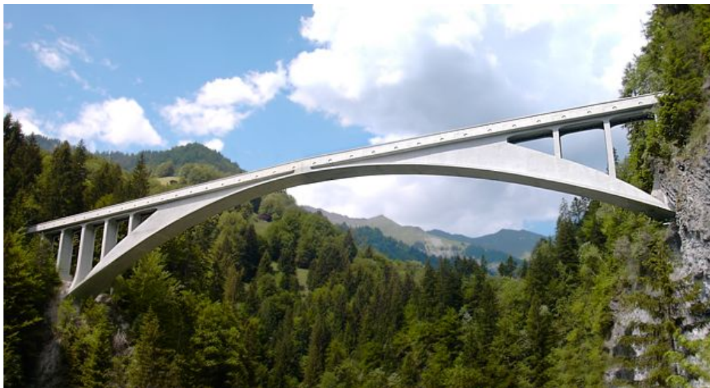
Fig. 2-31 – Ponte Salginatobel – Suíça (1930), arco tri-articulado
