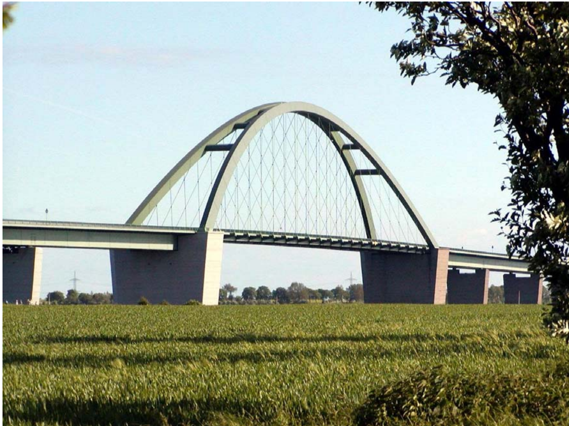
Fig. 2-35 – Ponte Fehmarnsund – Alemanha (1963), tabuleiro inferior
