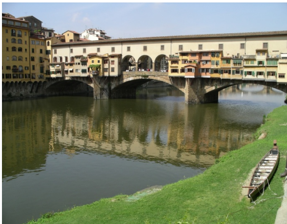
Fig. 2-5 – Ponte Vecchio – Florença (Pedro Quintela (2007))
