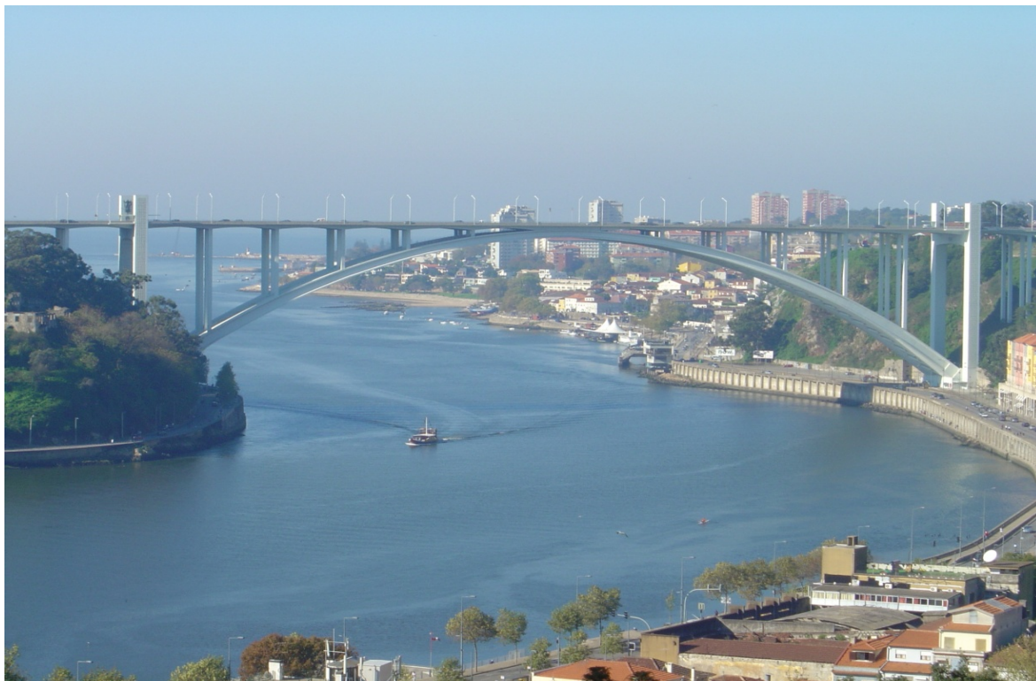
Fig. 2-18 – Ponte da Arrábida
