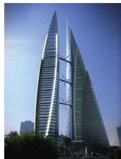
Figura 4.6 - WTC do Bahrein com turbinas integradas no edifício
