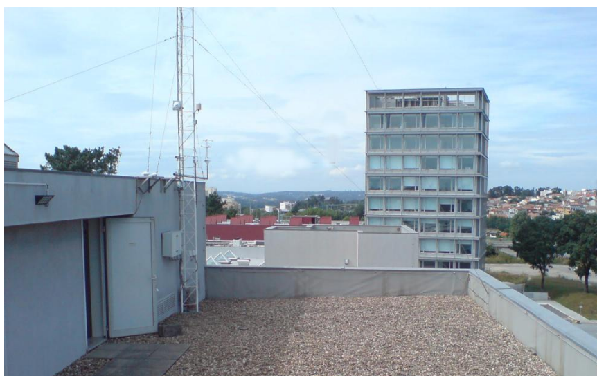
Figura 6.2 - Vista da cobertura do DEMec
