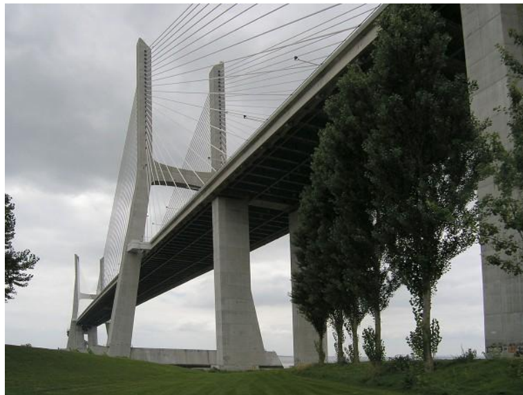
Figura 2.10 - Ponte Vasco da Gama, Lisboa (Kanakaris-Wirtl, 2006)
