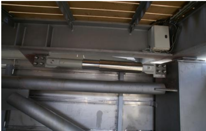
Figura 4.21 - Exemplo da utilização de um amortecedor viscoso na ponte Simone de Beauvoir – Paris (Duflot, et al., 2008)
