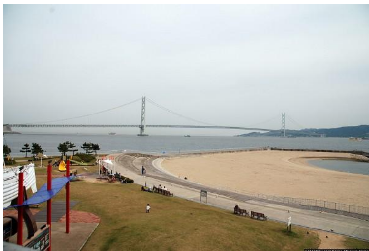
Figura 2.5 - Ponte Akashi-Kaikyo, Japão (Darger, 2007)
