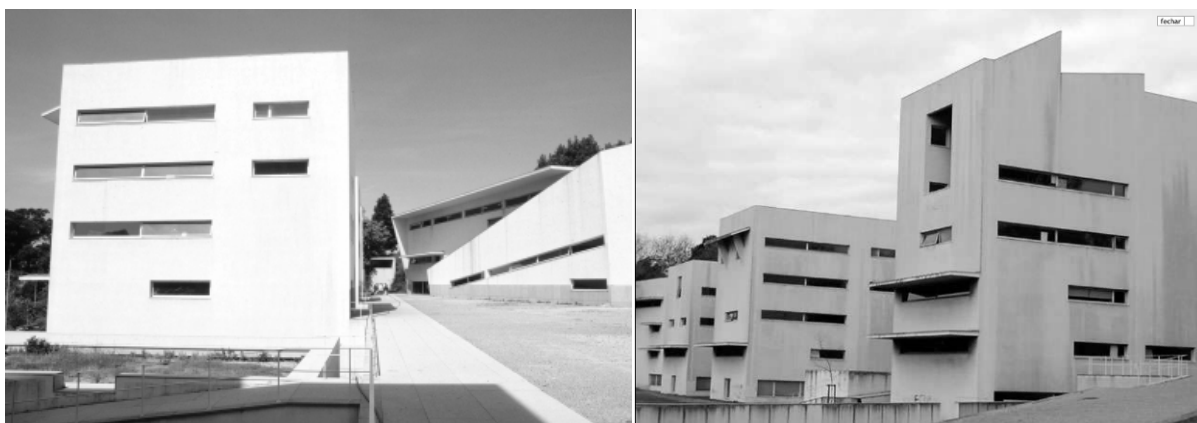
Fig.1.1 – Exemplo de uma estrutura laminar do tipo parede. Faculdade de Arquitectura da Universidade do Porto.
