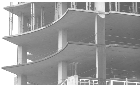
Fig.1.2 – Exemplo de uma laje de betão armado de um edifício residencial em construção.
