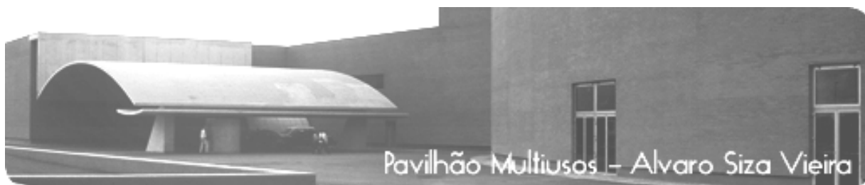
Fig.1.3 – Exemplo de uma estrutura tipo casca. Pavilhão Multiusos de Gondomar.
