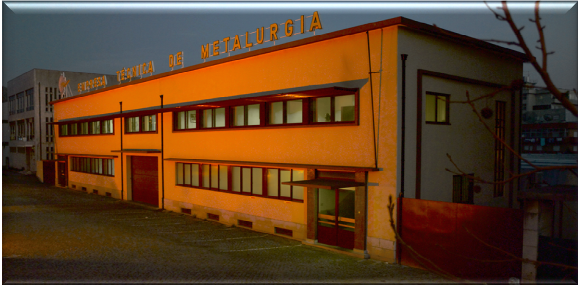
Figura 2 – Instalações da ETMA, S.A. e sua localização
