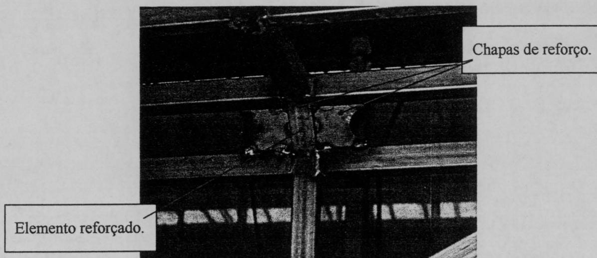
Figura. Solução de reforço aplicada nas ligações pilar – tejadilho (vista pelo interior)
