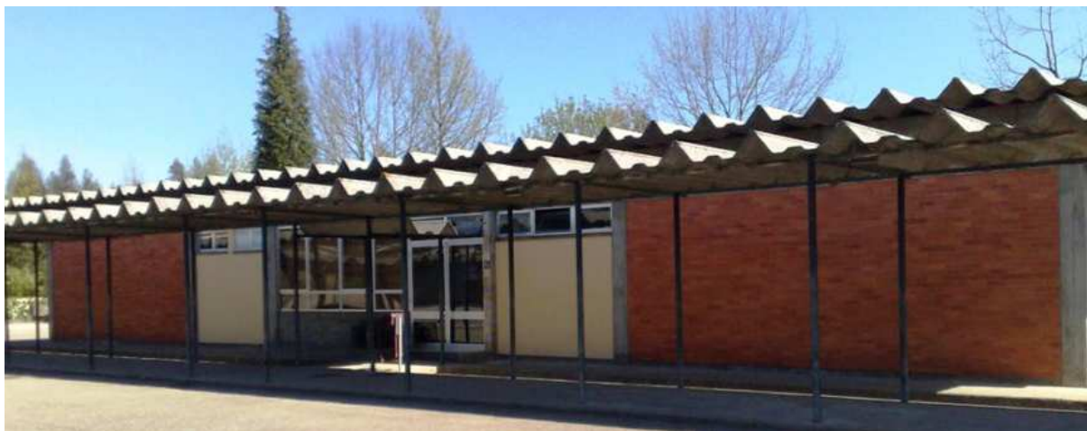
Figura 35 – Alçado Este do edifício escolar (Santos, 2010).
