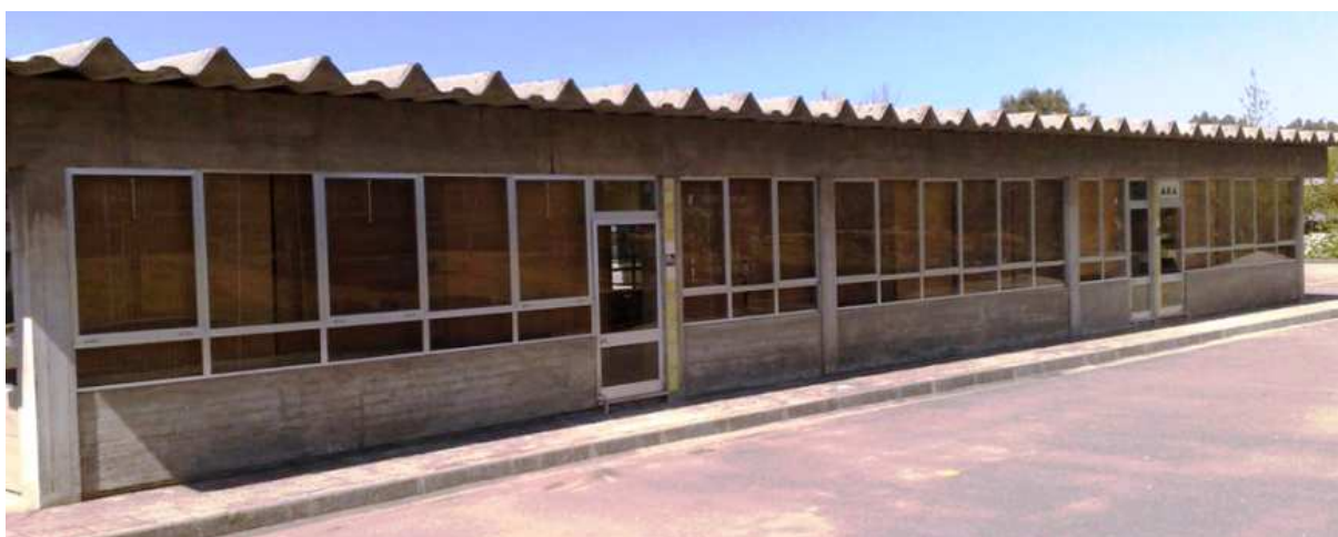
Figura 36 – Alçado Oeste do edifício escolar (Santos, 2010).
